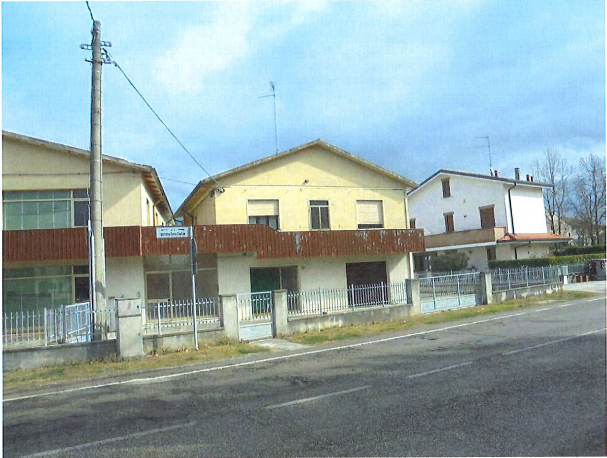
Foto 2. Prospetto Sud – Ovest. Vista da Via Provinciale.
