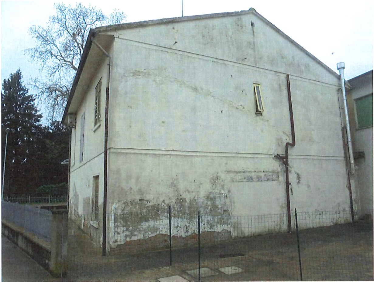
Foto 3. Prospetto Nord – Est. Vista da passo carrabile.
