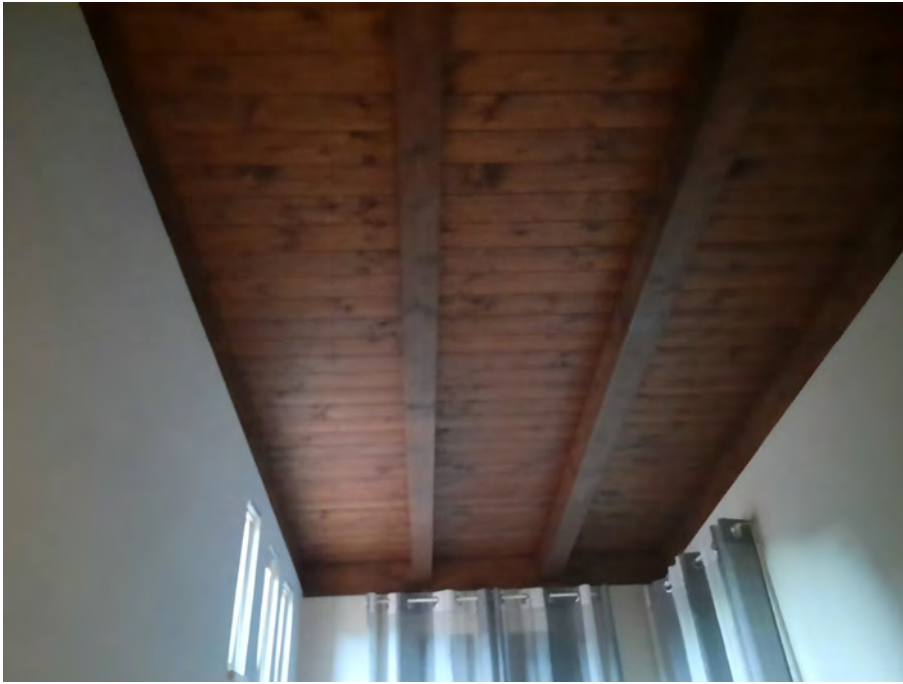
foto n°17 - appartamento su due livelli | p. sottotetto - "zona notte" - seconda camera (copertura del terrazzino di "tipo a tasca")
