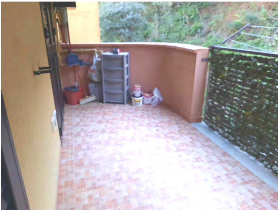
foto n°10 - appartamento su due livelli | p. secondo - "zona giorno" - balcone | vista 1
