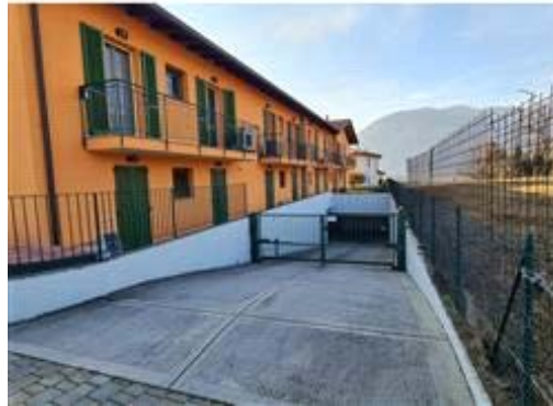
Viste esterne del condominio e della rampa di accesso al piano interrato.
