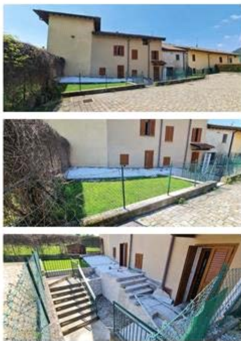
Viste esterne terreno.
