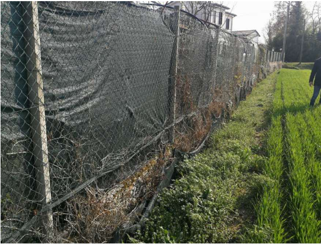
Fotografia n. 07 – Terreni, confine con rete metallica lato Est
