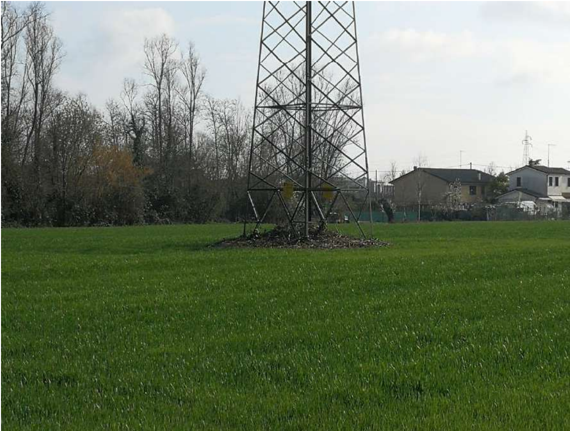
Fotografia n. 05 – Traliccio elettrico posto all'interno del Lotto
