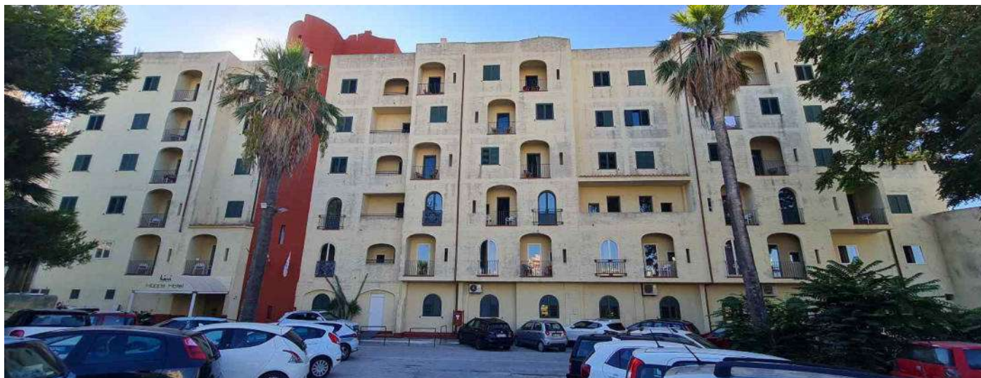
Foto 06 – prospetto sulla strada privata (dal parcheggio).
