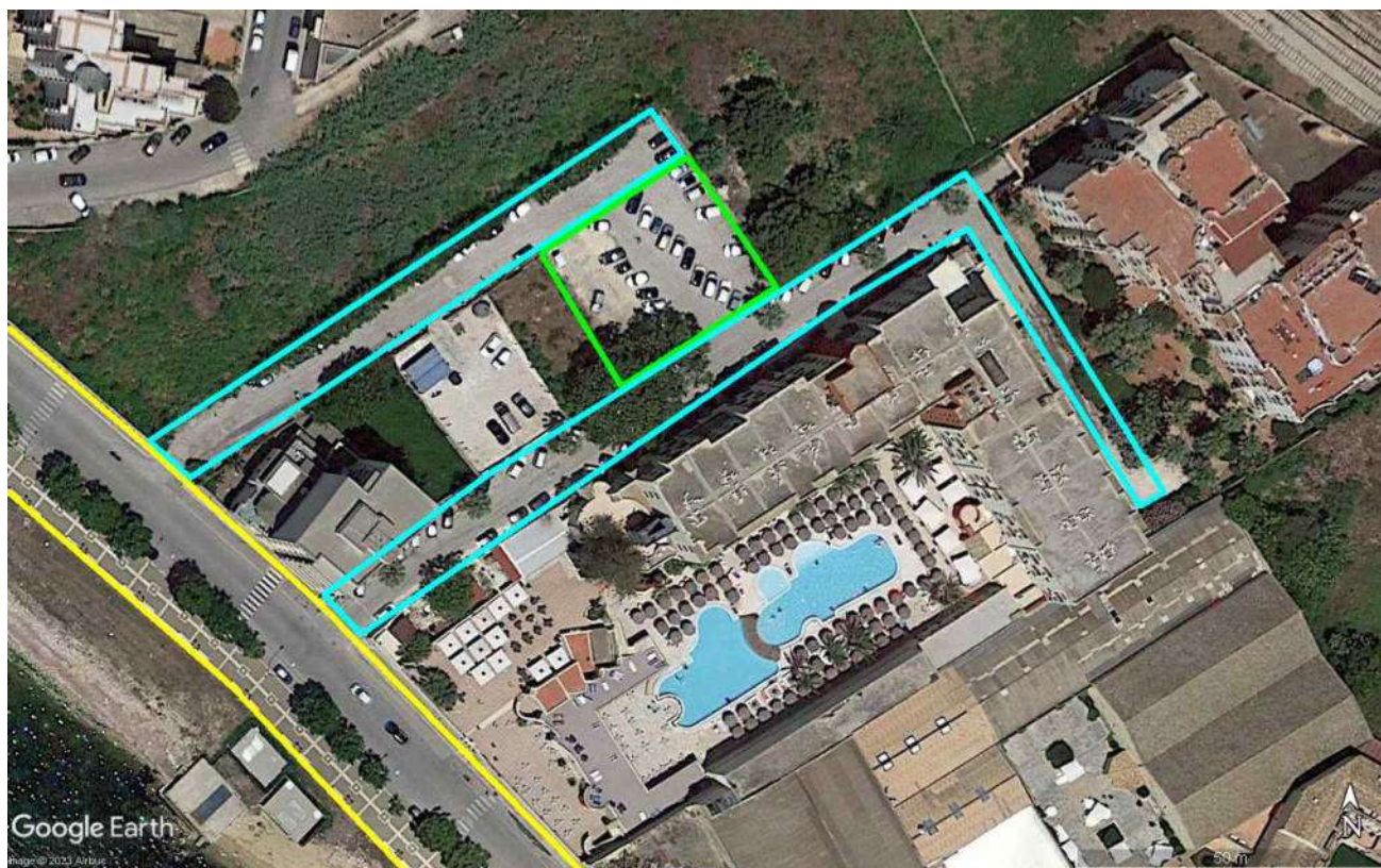
Foto 12 – evidenziate in celeste le due stradelle di accesso ed in verde l'area a parcheggio (partt. 195-196).
