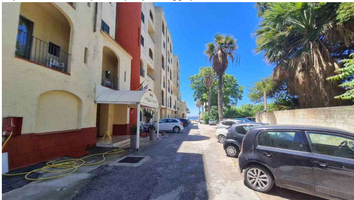
Foto 07 – prospetto sulla strada privata.
