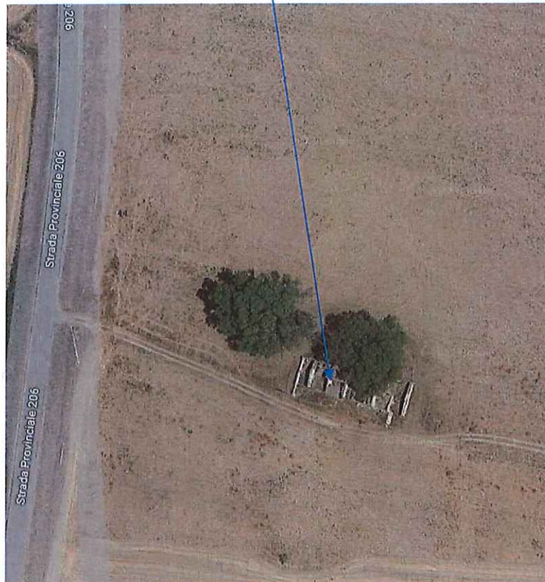
Aerofotogrammetria del fabbricato diroccato posto all'interno della part. 78
