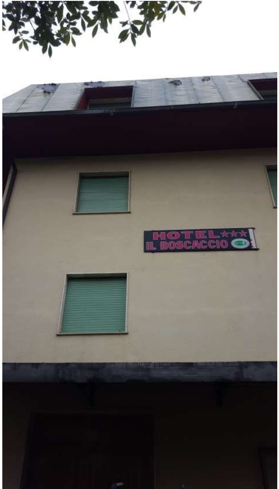
Foto 2- facciata di ingresso
