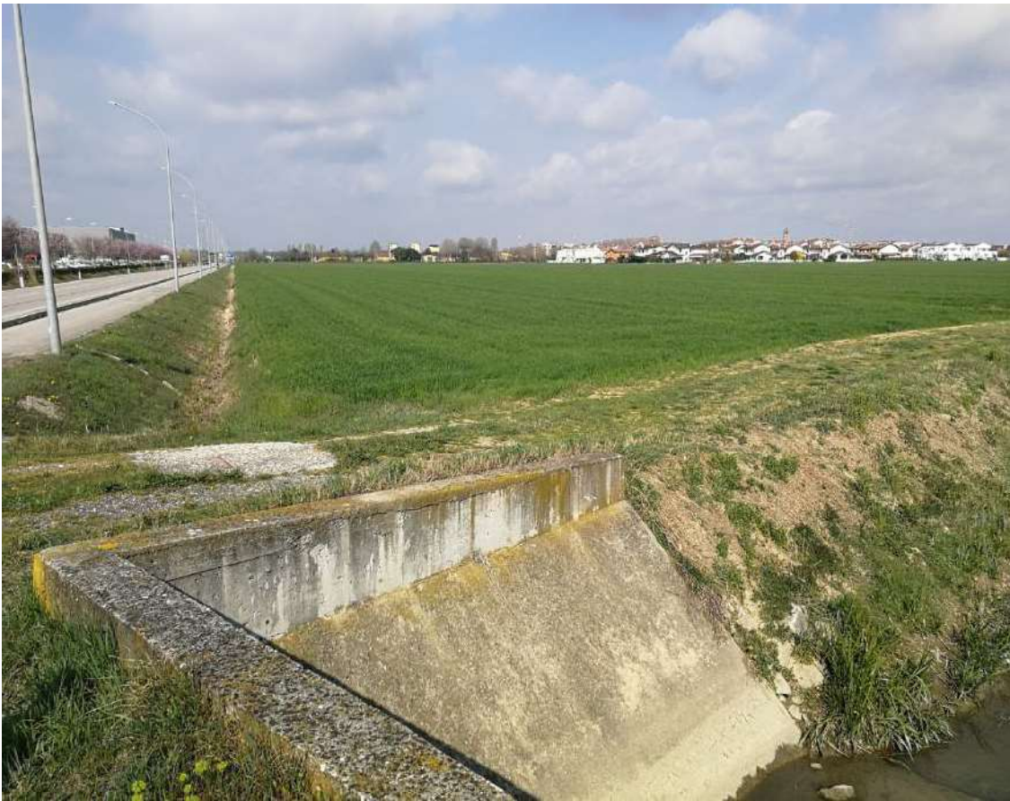
Fotografia n. 07 – Scolo Consorziale al confine Sud dei terreni
