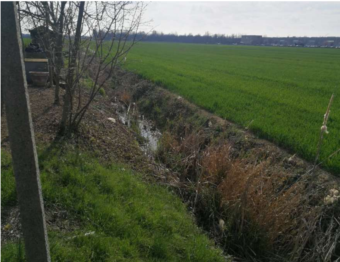
Fotografia n. 04 – Scolina al confine Ovest dei terreni
