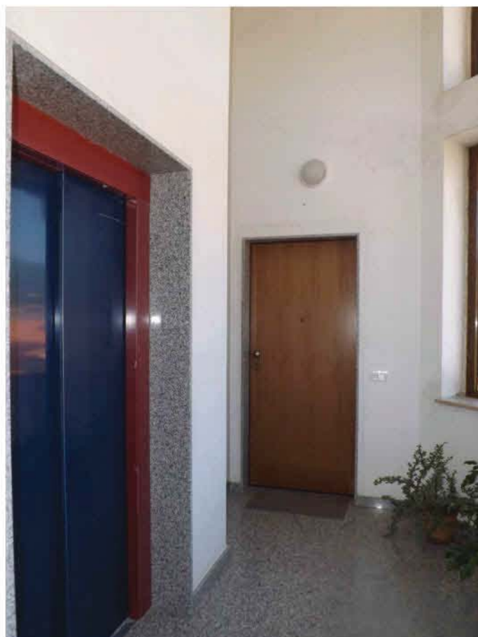
LA PORTA DI INGRESSO ALL'ALLOGGIO
