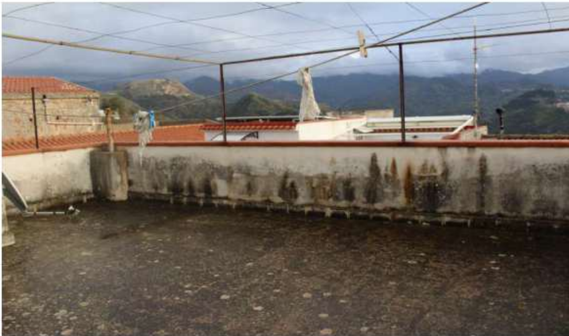
Lastrico Solare Piano Secondo
