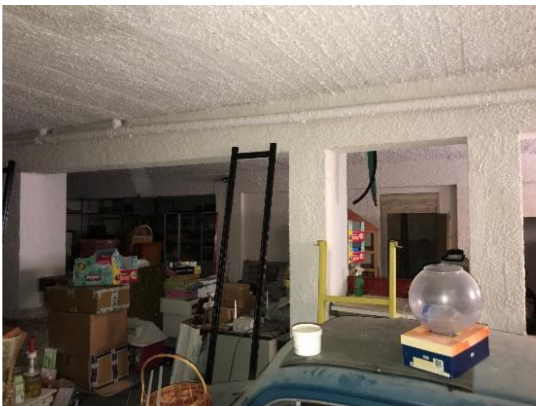
Foto 2.12 – Particolare del magazzino al piano seminterrato su Via Largo Pecorelle
