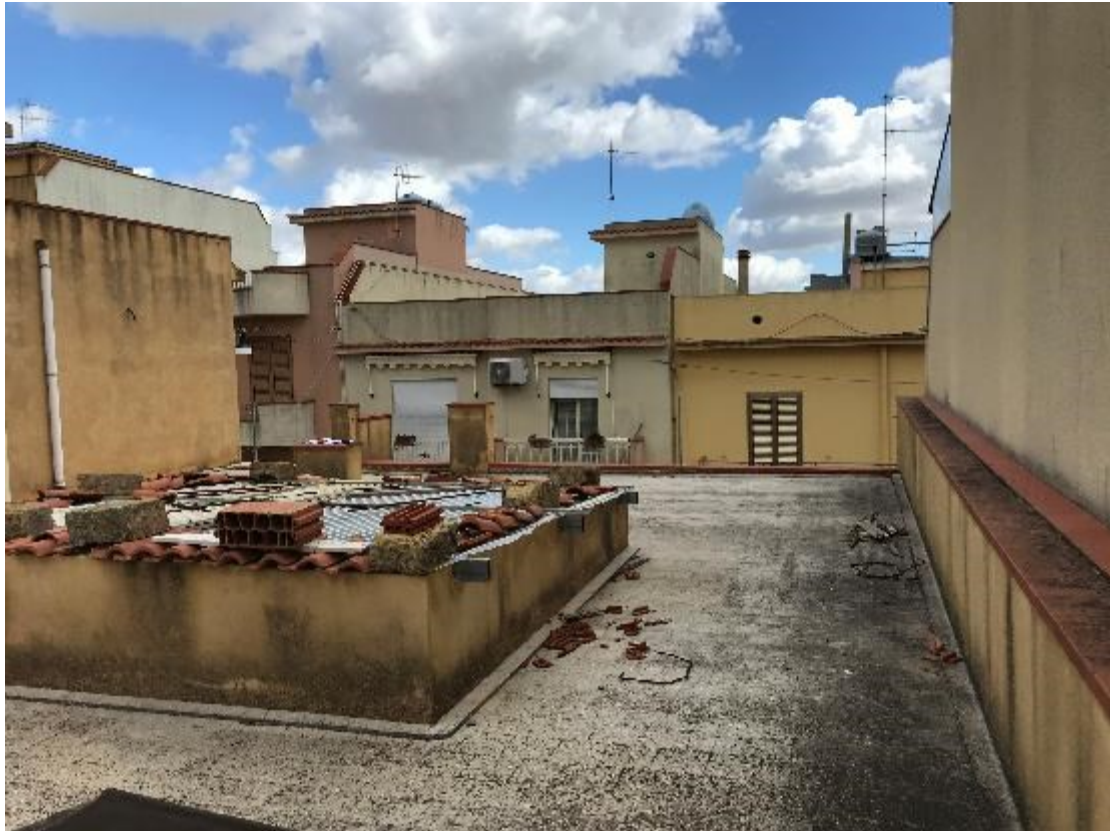
Foto 2.5 – Copertura del fabbricato sito nel Comune di Partanna (TP) in Via Largo Pecorelle nn. 13-15
