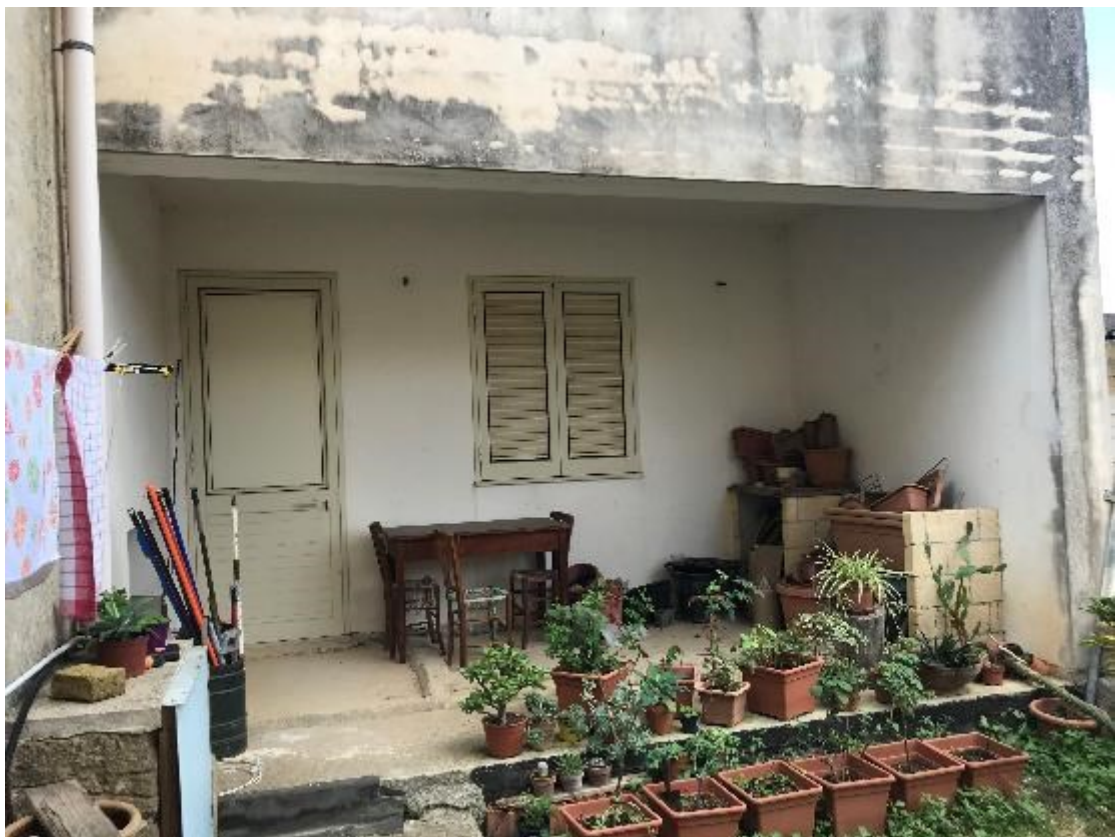
Foto 2.4 – Particolare del prospetto del fabbricato – Lato Nord
