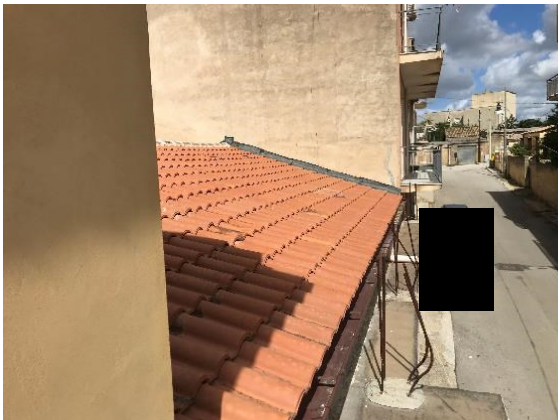
Foto 1.6 – Particolare della copertura del fabbricato su Via Largo Pecorelle
