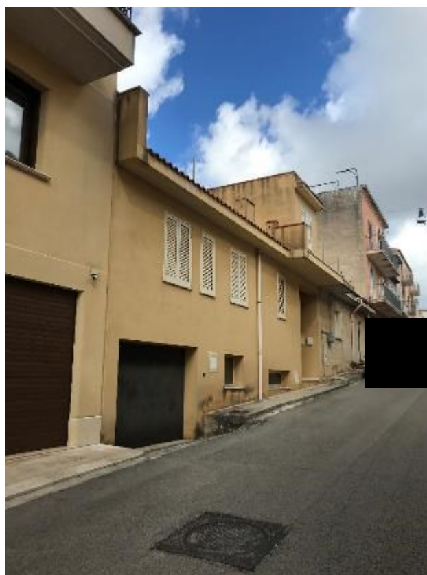
Foto 2.8 – Ingresso al magazzino al piano seminterrato su Via Largo Pecorelle
