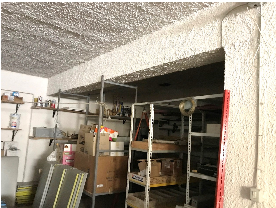
Foto 2.14 – Particolare del magazzino al piano seminterrato su Via Largo Pecorelle
