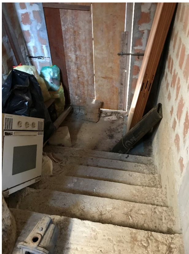
Foto 2.17 – Accesso del piano terra del fabbricato su Via Largo Pecorelle
