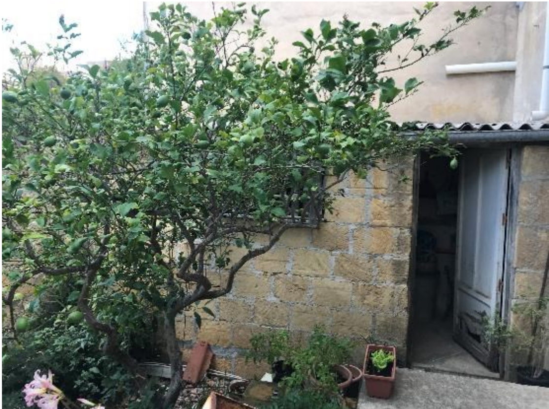
Foto 1.19 – Ripostiglio del fabbricato di Via Largo Pecorelle n. 17
