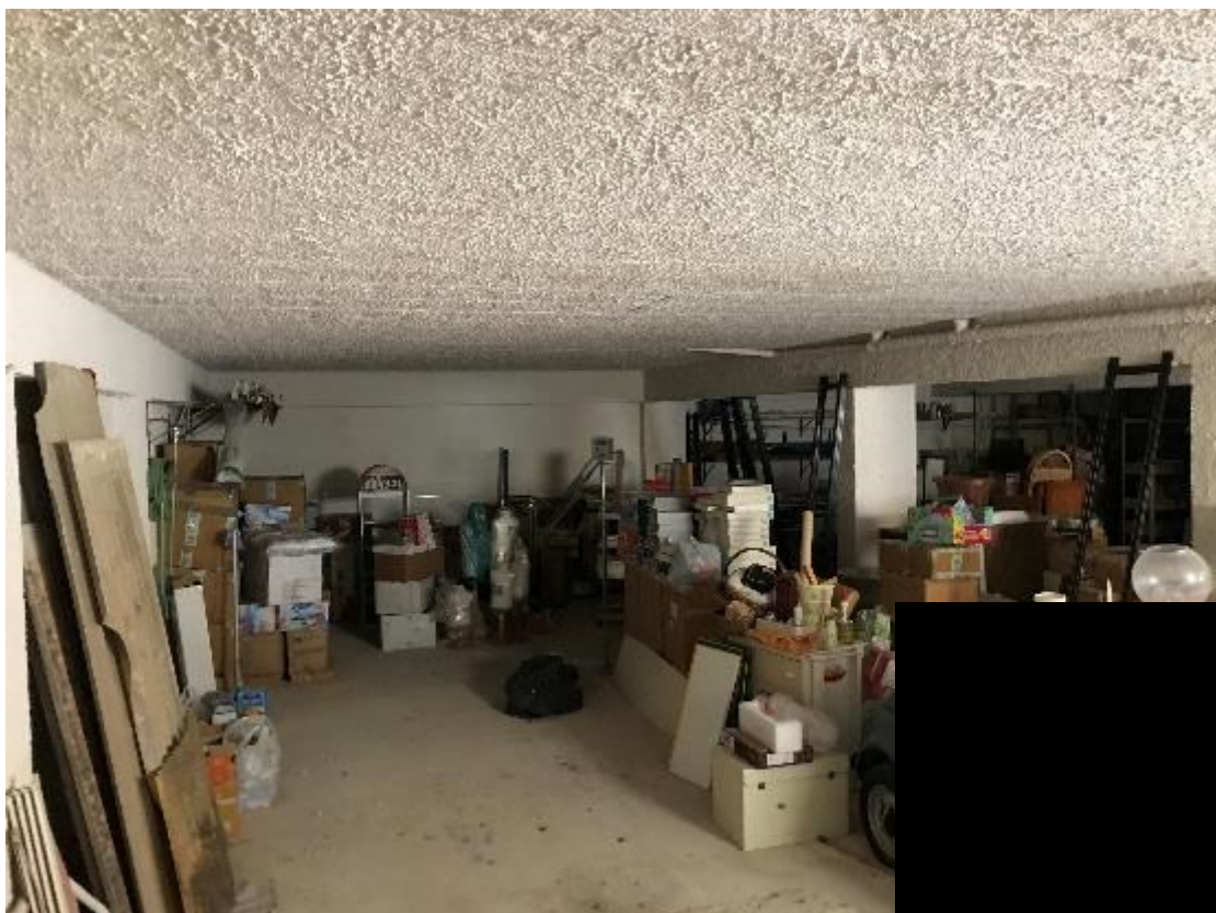
Foto 2.10 – Magazzino al piano seminterrato su Via Largo Pecorelle
