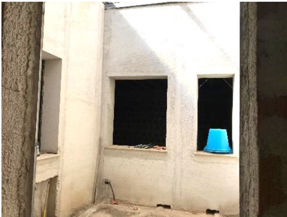
Foto 2.31 – Chiostrina dell'immobile di piano terra
