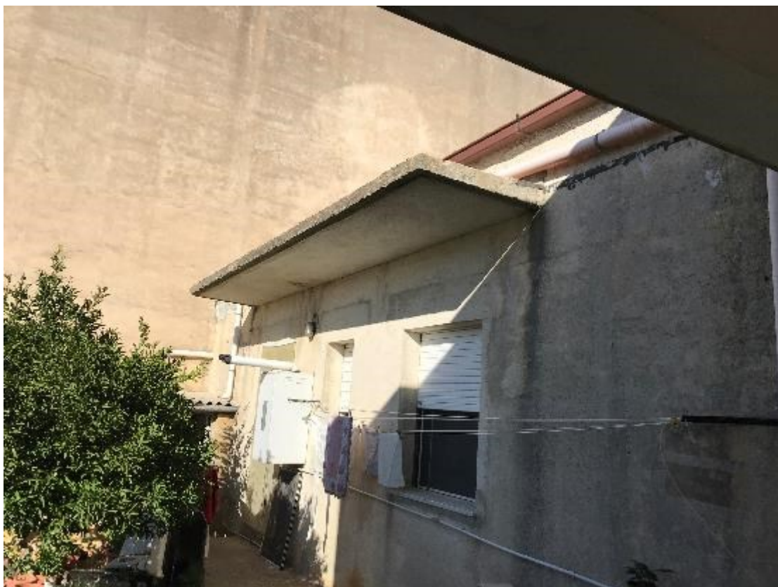
Foto 1.4 – Particolare del prospetto del fabbricato – Lato Ovest
