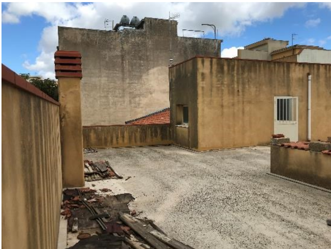
Foto 2.7 – Particolare della copertura destinata a terrazza piana praticabile
