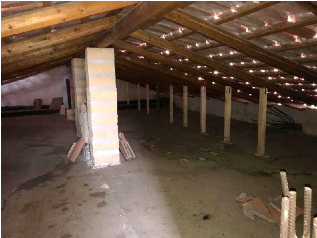
Foto 1.24 – Copertura delle due falde inclinate del fabbricato di Via Largo Pecorelle n. 17
