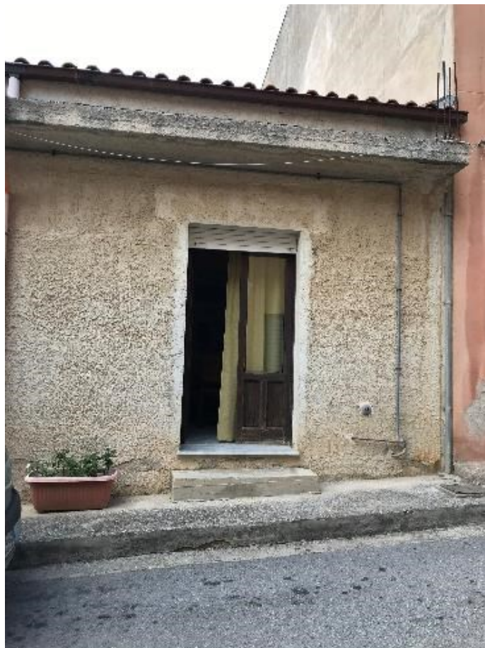
Foto 1.7 – Particolare dell'ingresso al fabbricato su Via Largo Pecorelle n. 17
