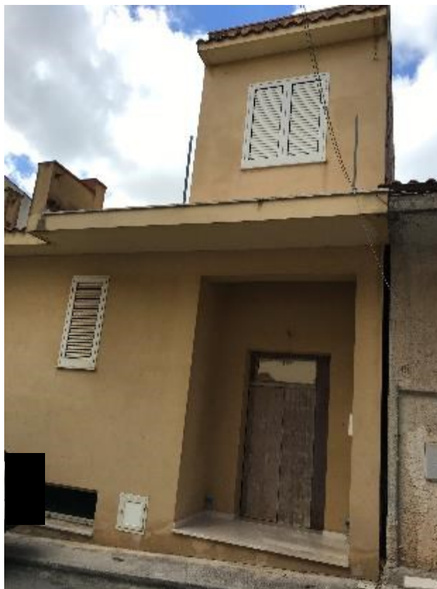
Foto 2.9 – Ingresso all’abitazione del fabbricato su Via Largo Pecorelle
