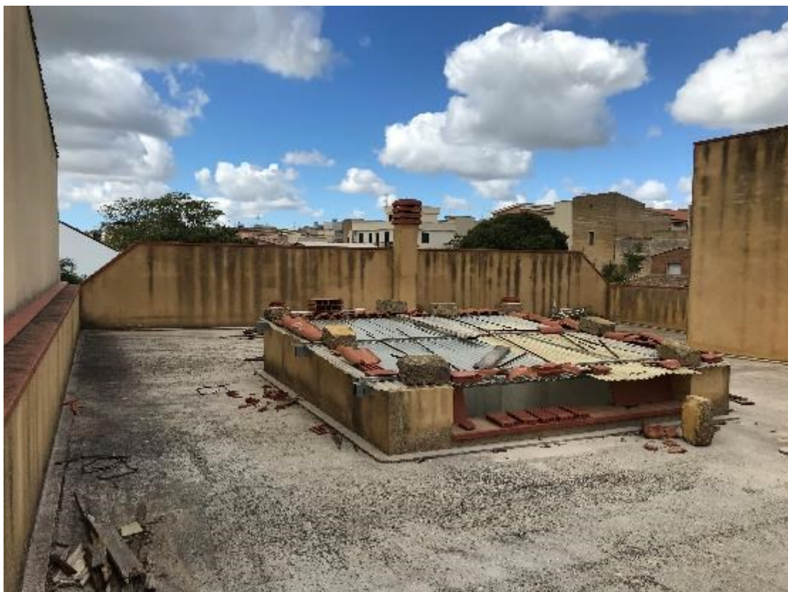
Foto 2.6 – Particolare della copertura destinata a terrazza piana praticabile
