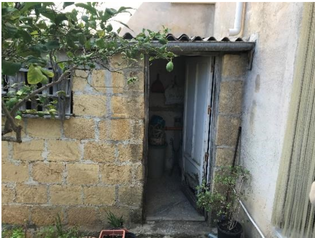
Foto 1.20 – Particolare della porta di accesso del ripostiglio
