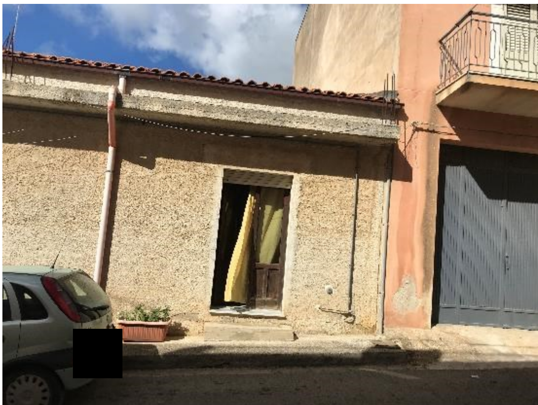
Foto 1.2 – Ingresso al fabbricato sito nel Comune di Partanna (TP) su Via Largo Pecorelle n. 17
