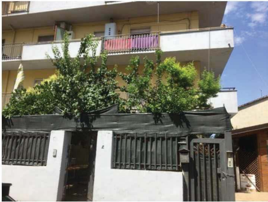
Cancello d'ingresso su strada
