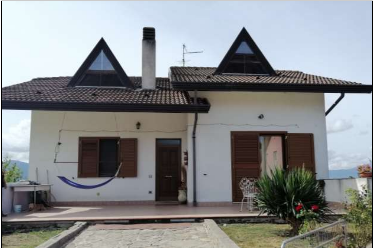
FOTO 01 esterni - prospetto principale lato ingresso abitazione
