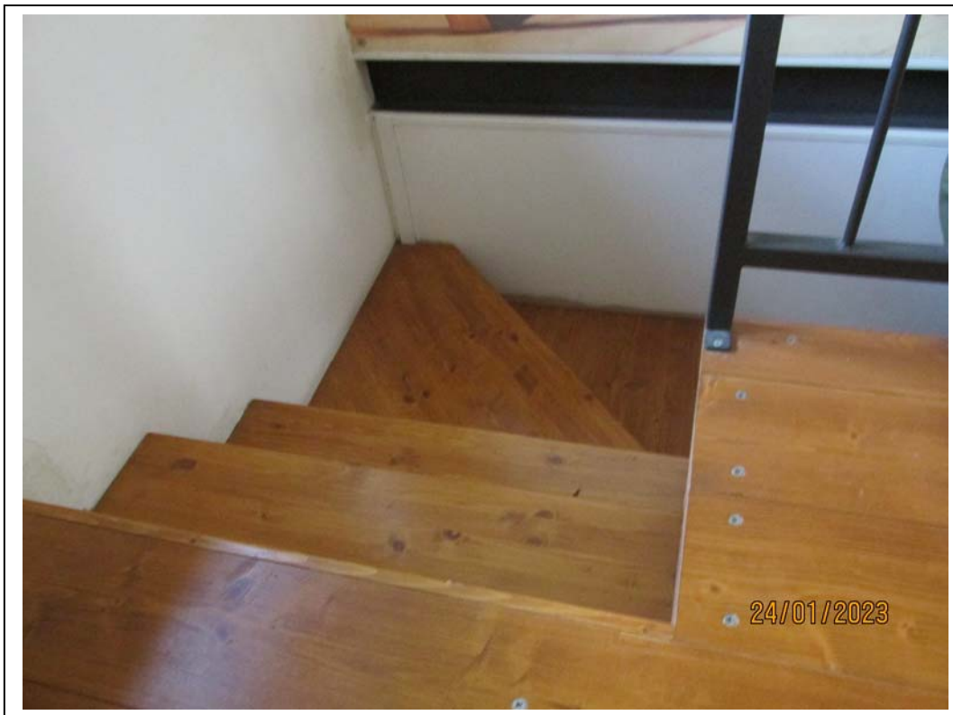
EDIFICIO PRINCIPALE (PIANO 2° - SOTTOTETTO)
