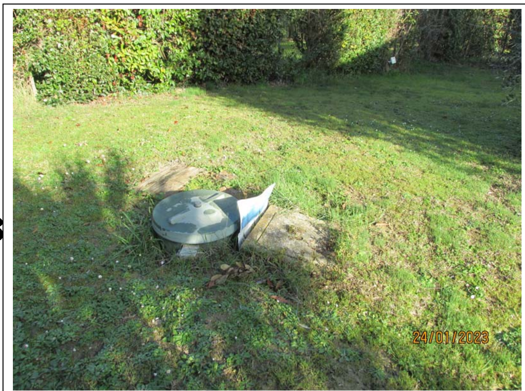
TERRENO (SERBATOIO GPL)
