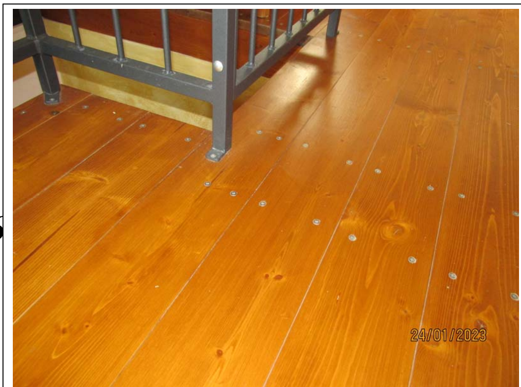
EDIFICIO PRINCIPALE (PIANO 2° - SOTTOTETTO)
