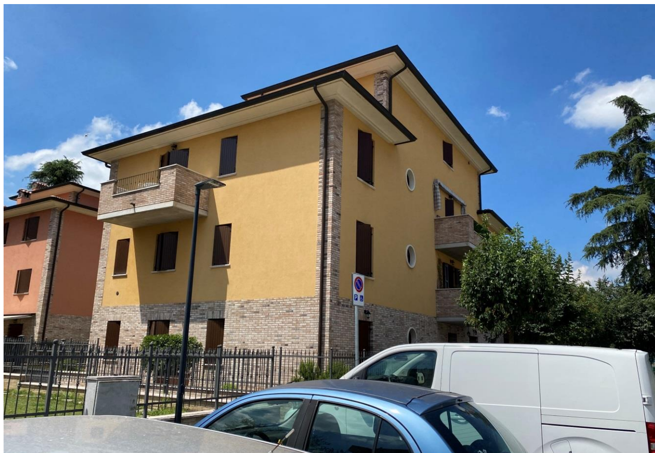
Fotografia 2 – Prospetti nord ed est
