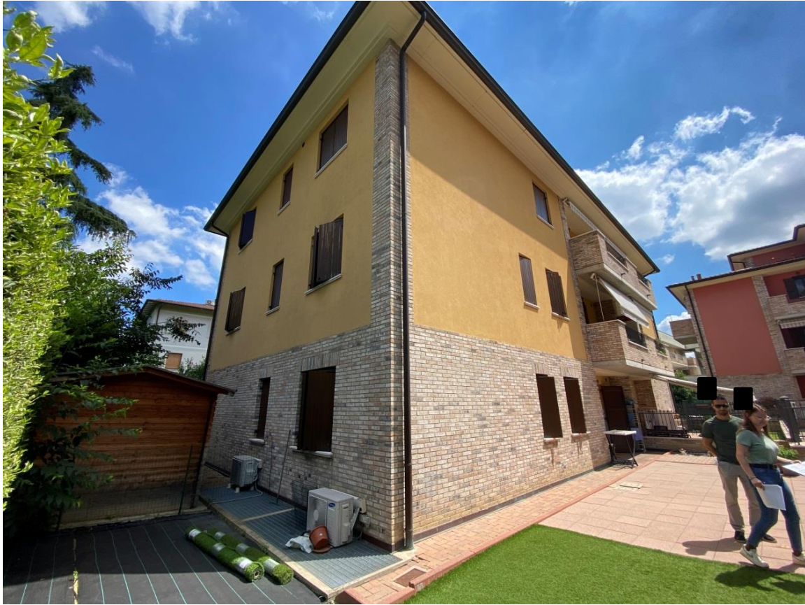
Fotografia 3 – Prospetti sud ed ovest
