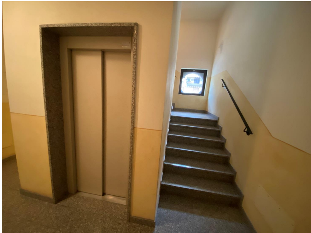
Fotografia 10 – Locali condominiali comuni: vano scala e vano ascensore
