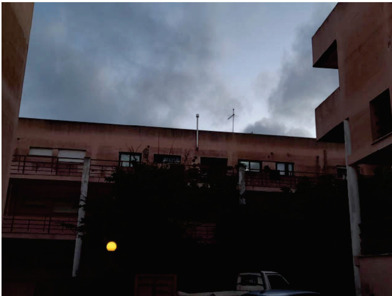
Foto 1: Vista Esterno con Ingresso piano 2°
