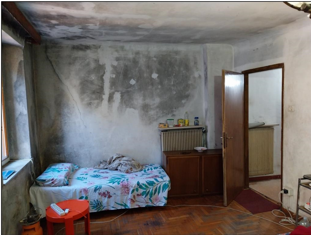
8) Piano primo - camera
