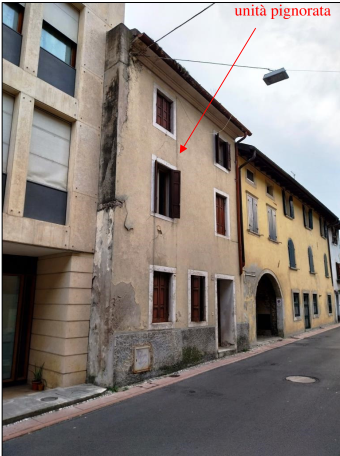
1) Fronte nord – su via L. Da Ponte
