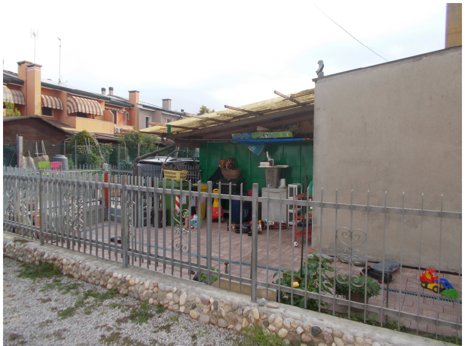
Foto 4- Vista cortile/retro da ovest
