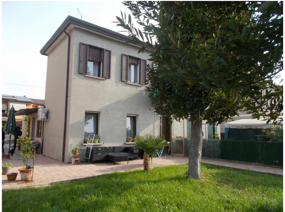
Foto 3- Vista cortile da sud ovest
