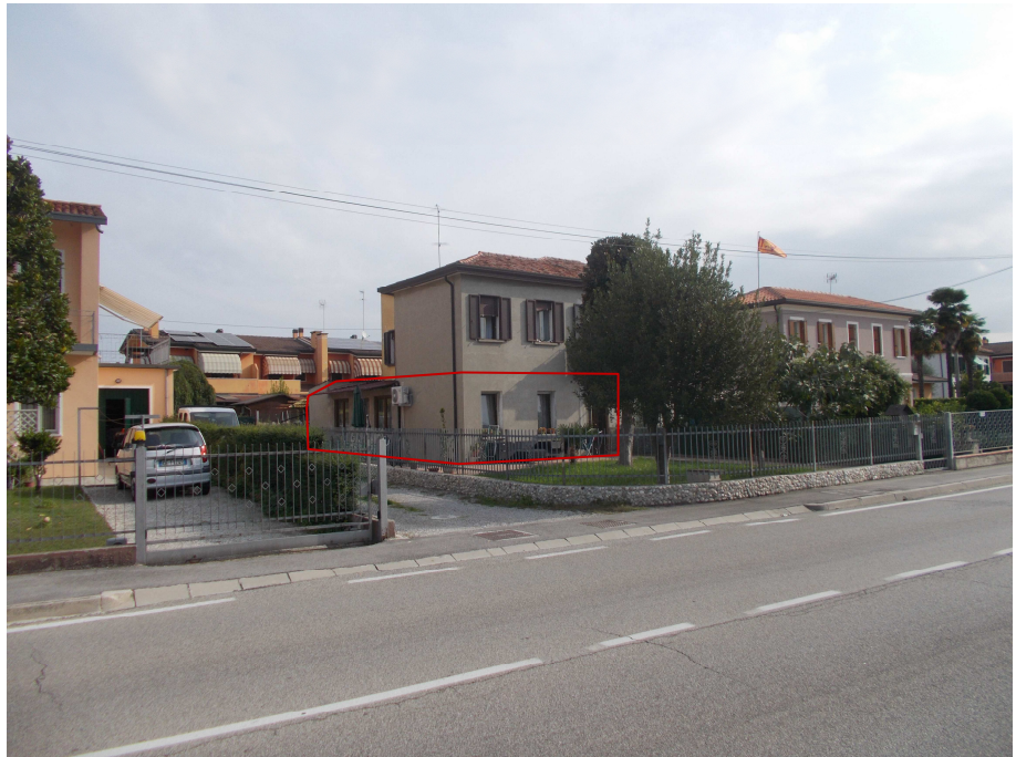
Foto 1- Vista esterna da sud ovest con accesso carrabile
