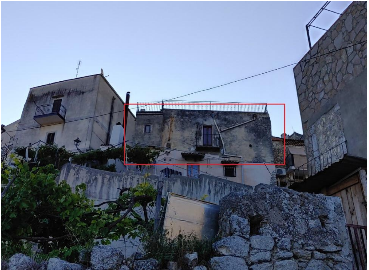
Foto C1 - LOTTO 1 - FABBRICATO - PROSPETTO DI VIA DE NITTIS
