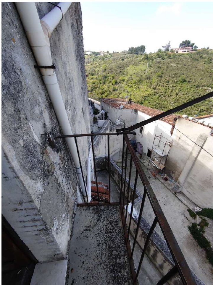
Foto C13 - LOTTO 1 - ABITAZIONE - BALCONE
