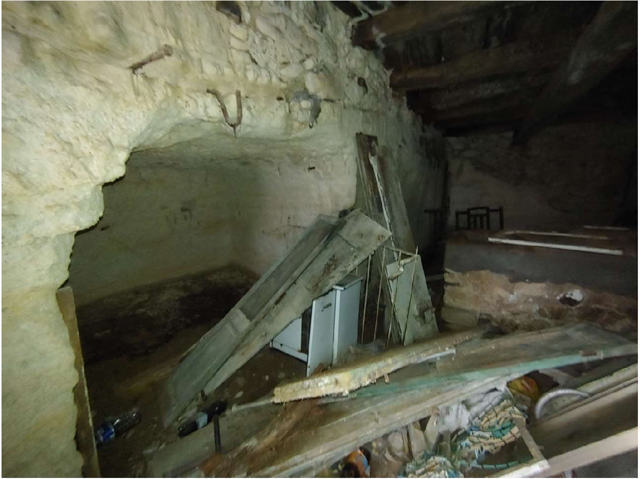
Foto C44 - LOTTO 3 - DEPOSITO -INTERNO
