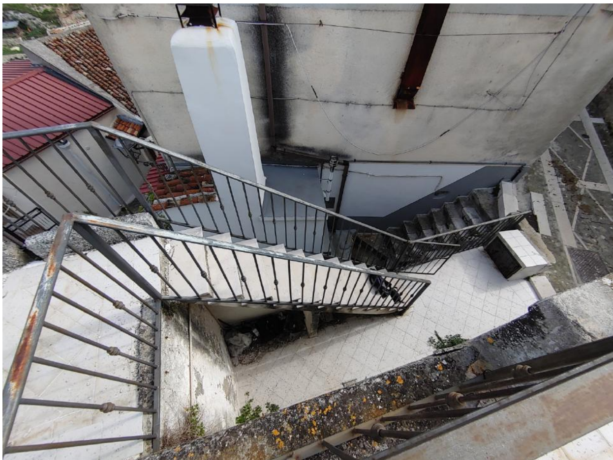
Foto C7 - LOTTO 1 - FABBRICATO - BALLATOIO/SCALINATA ESTERNA
