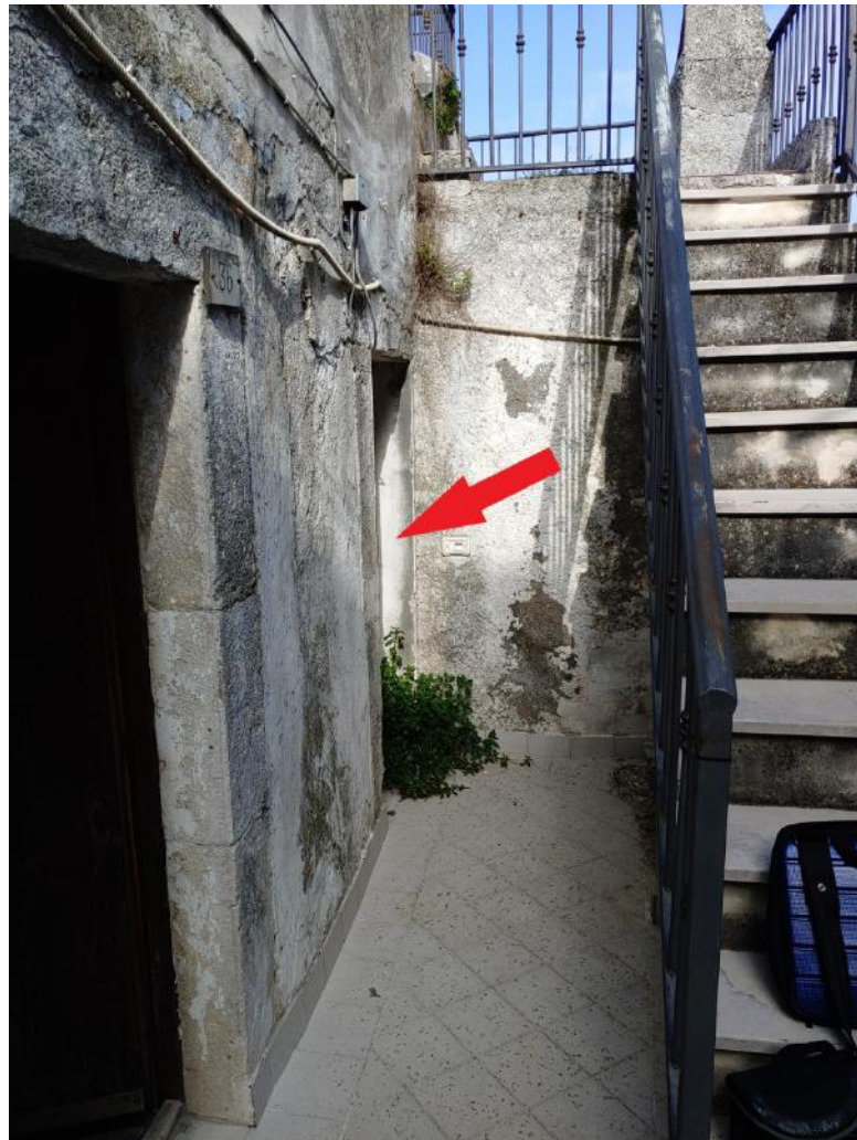
Foto C4 - LOTTO 1 - FABBRICATO - INGRESSO CIV. 33 DI VIA CASALE
