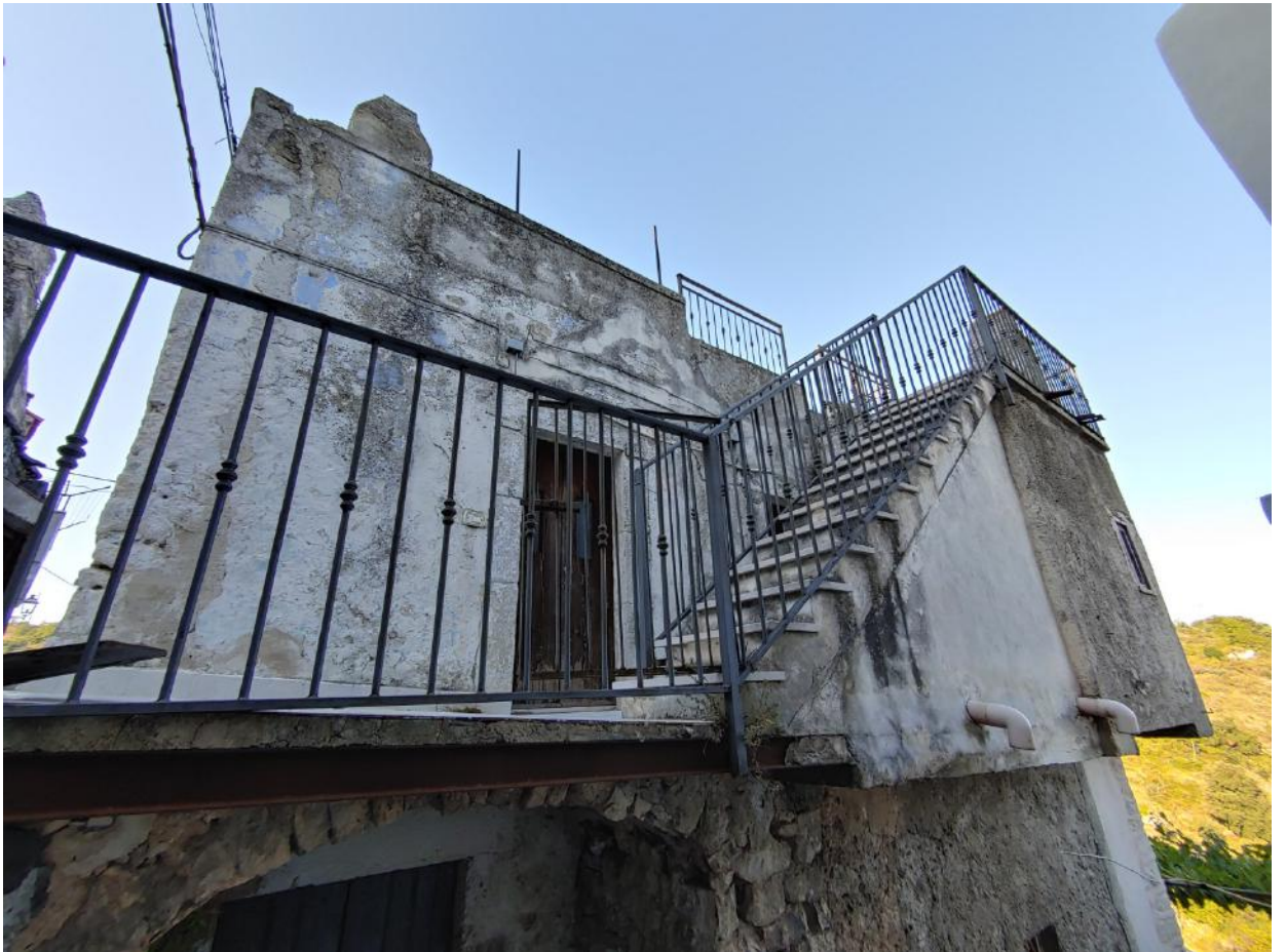
Foto C24 - LOTTO 2- FABBRICATO - PROSPETTI SU VIA CASALE
