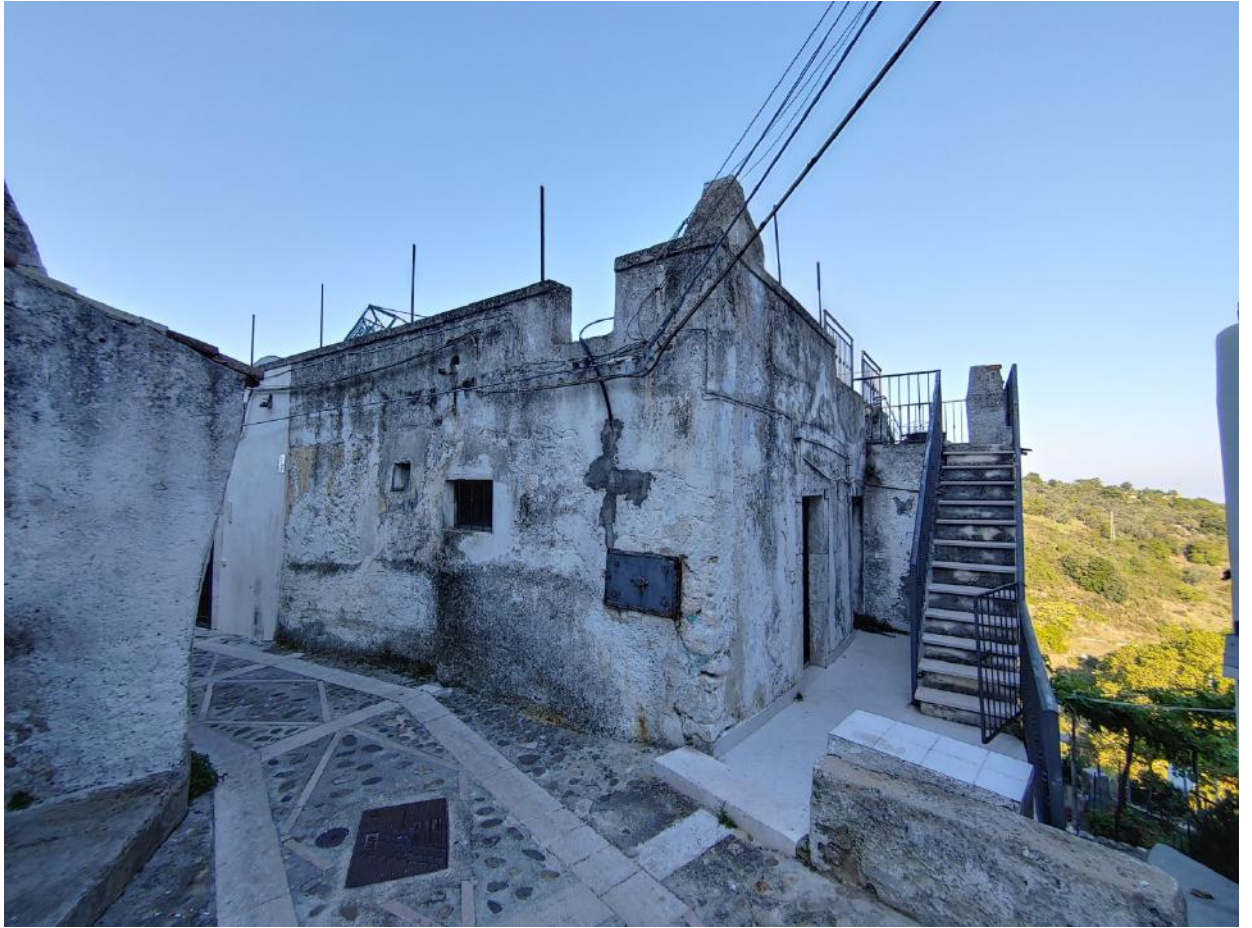
Foto C23 - LOTTO 2 - FABBRICATO - PROSPETTI SU VIA CASALE
