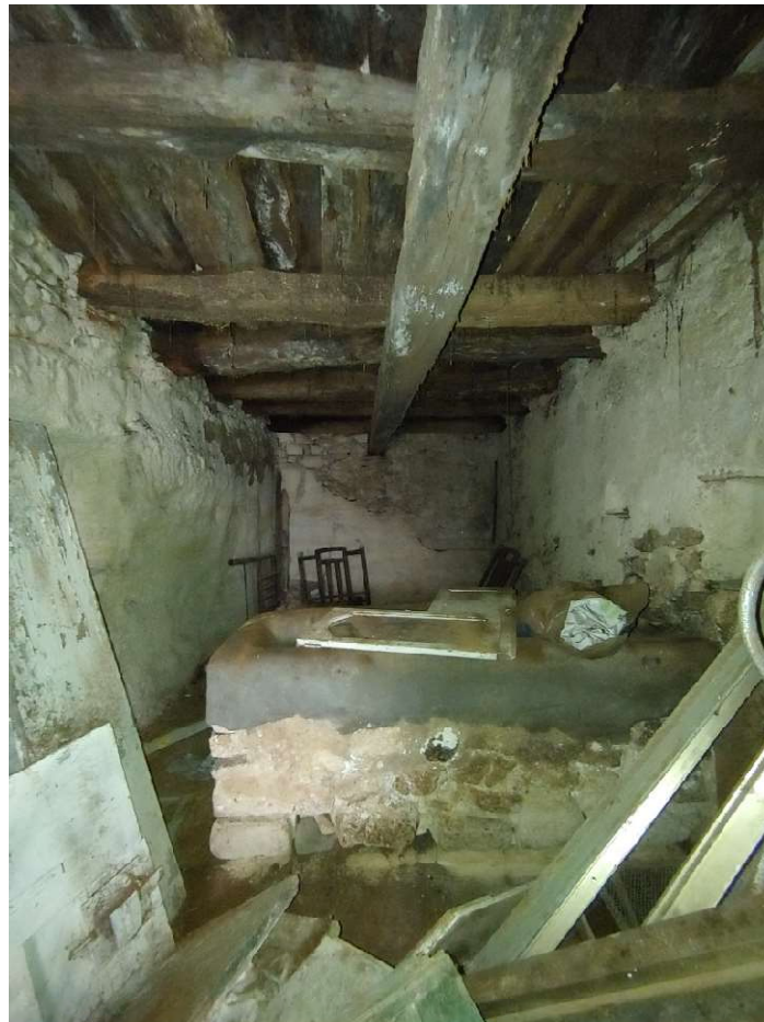
Foto C43 - LOTTO 3 – DEPOSITO – INTERNO
