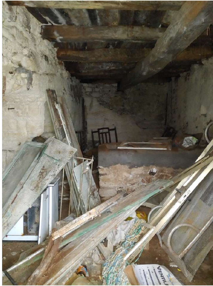
Foto C42- LOTTO 3 – DEPOSITO – INTERNO
