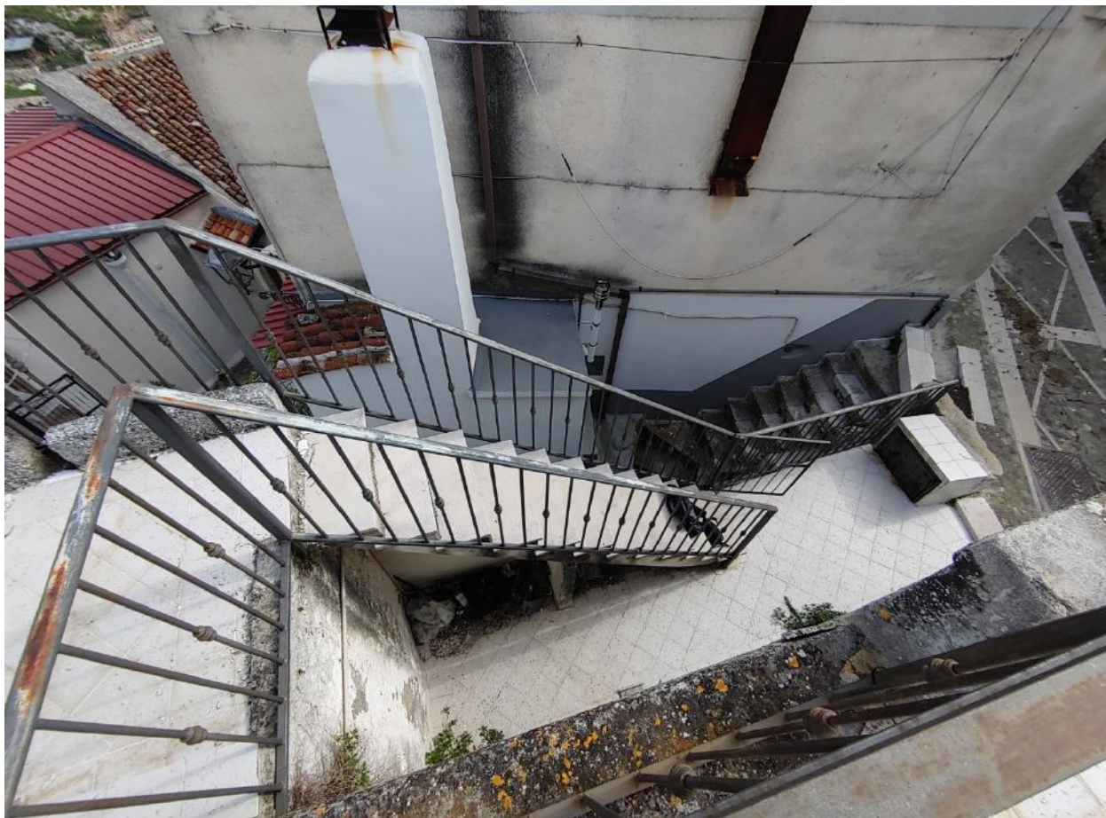
Foto C27 - LOTTO 2 - FABBRICATO - BALLATOIO/SCALINATA ESTERNA
