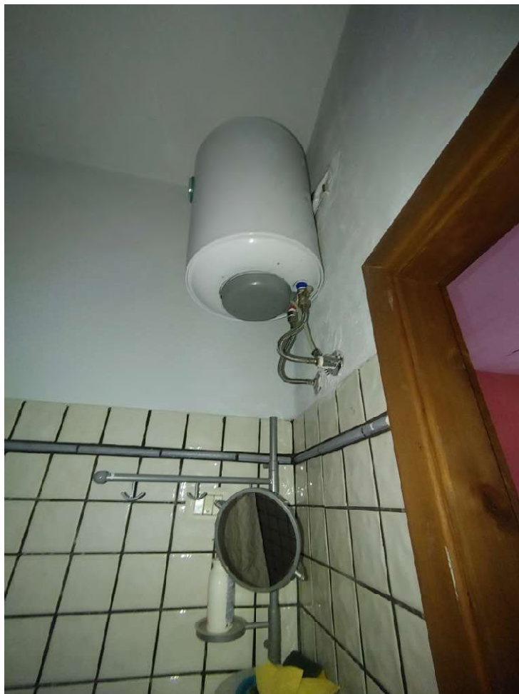
Foto C37 - LOTTO 2 - ABITAZIONE - BAGNO
