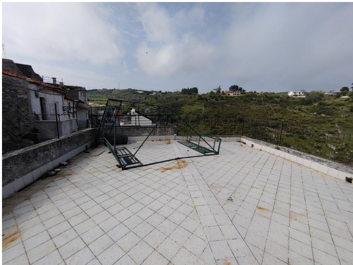
Foto C28 - LOTTO 2 - FABBRICATO - COPERTURA PRATICABILE
