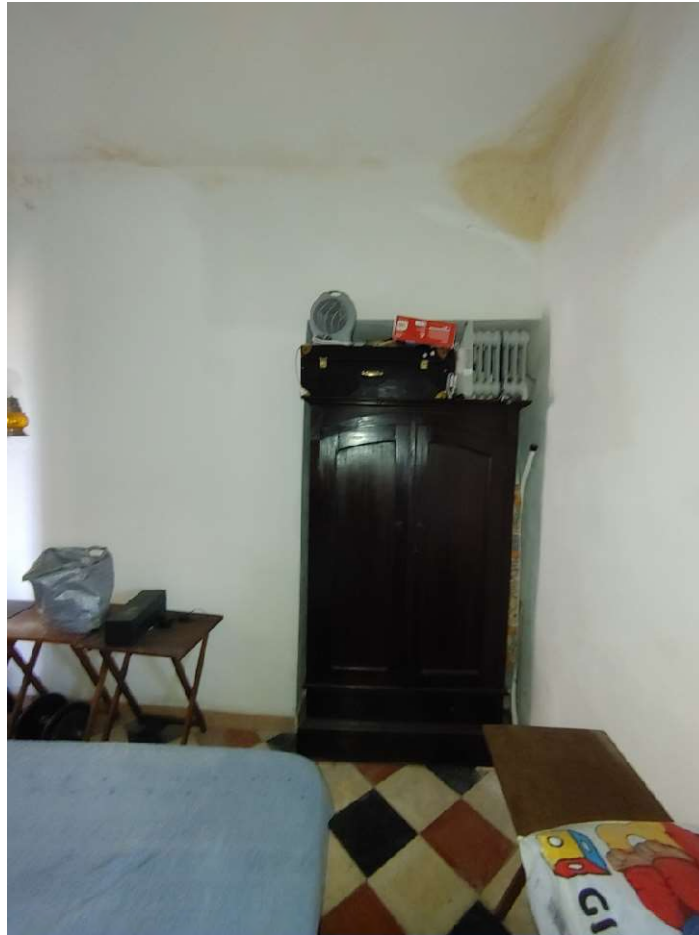
Foto C21 - LOTTO 1 - ABITAZIONE - CAMERA DA LETTO
