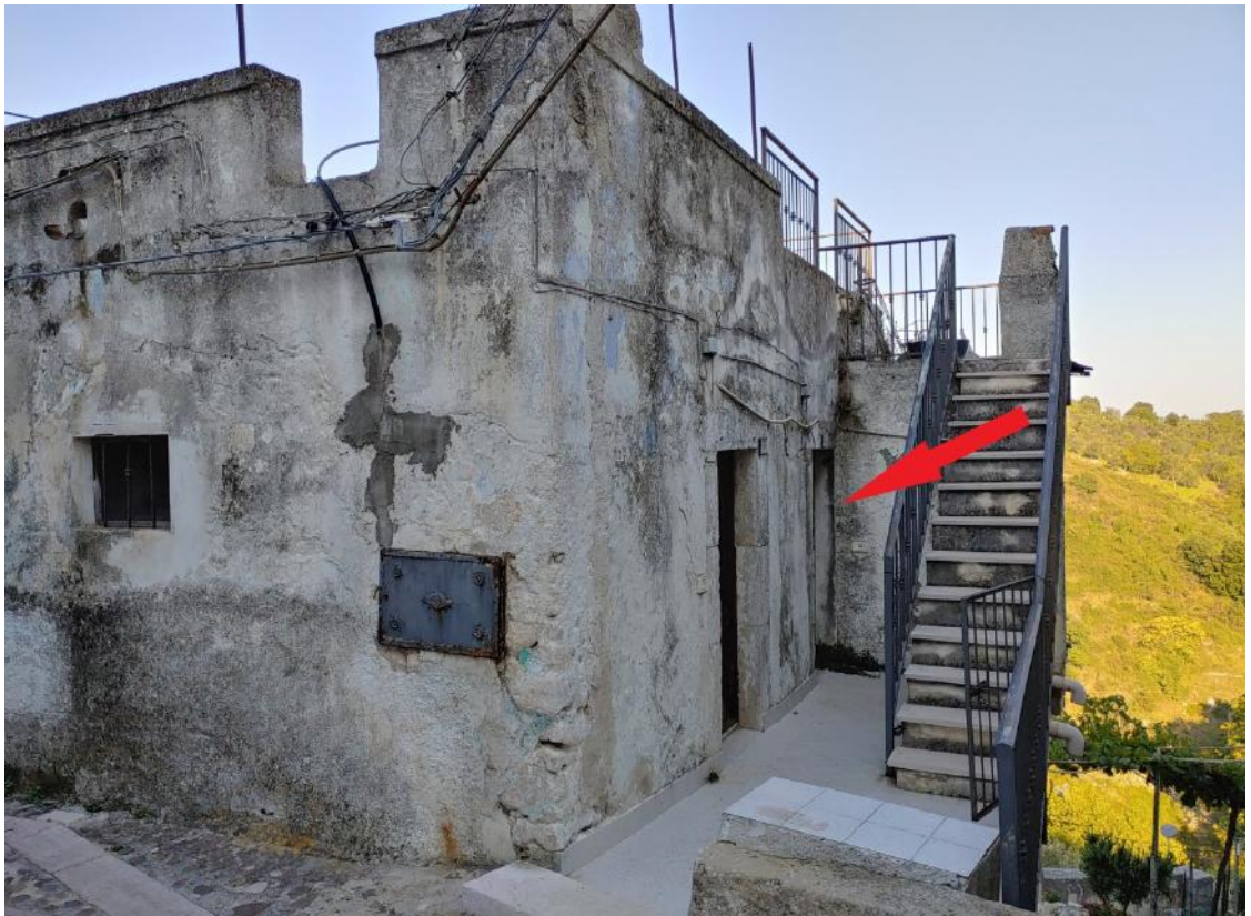
Foto C3 - LOTTO 1 - FABBRICATO - INGRESSO CIV. 33 DI VIA CASALE
