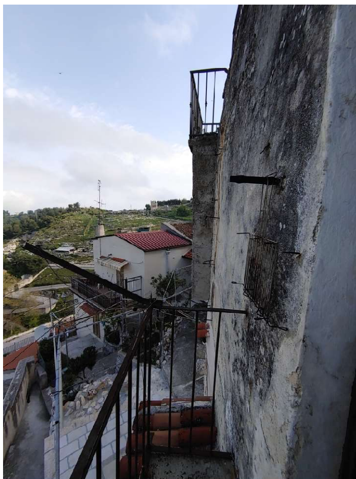
Foto C14 - LOTTO 1 - ABITAZIONE - BALCONE
