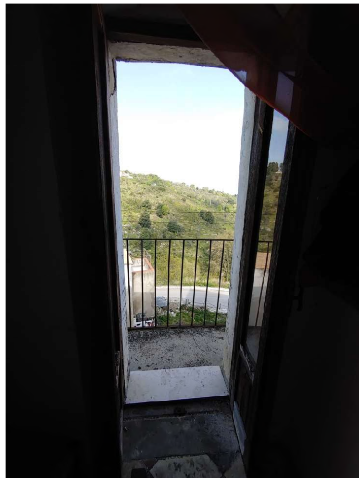
Foto C12 - LOTTO 1 - ABITAZIONE - BALCONE
