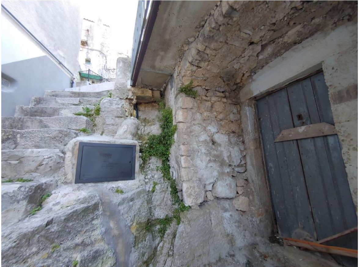
Foto C40 - LOTTO 3 - DEPOSITO - FABBRICATO - PROSPETTO SU VIA CASALE
