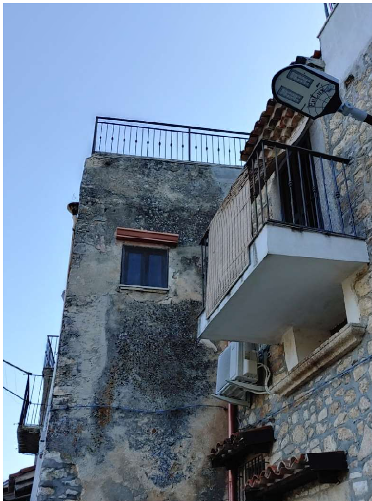
Foto C5 - LOTTO 1 - FABBRICATO - PROSPETTO VIA DE NITTIS
