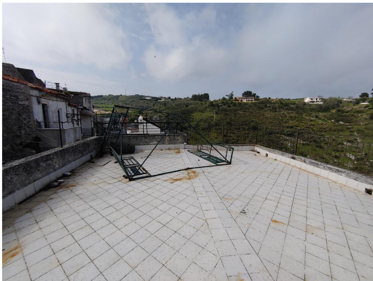
Foto C8 - LOTTO 1 - FABBRICATO - COPERTURA PRATICABILE
