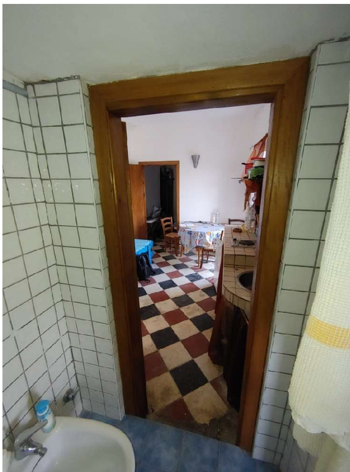
Foto C18 - LOTTO 1 - ABITAZIONE - BAGNO
