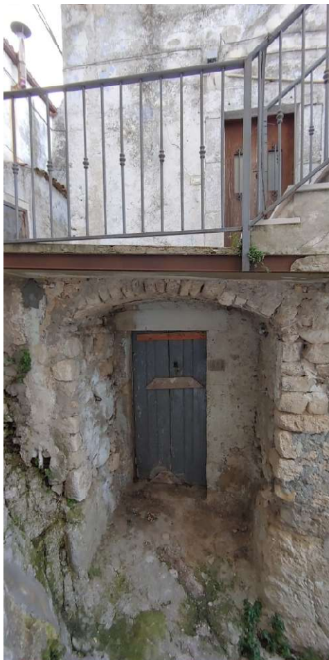
Foto C38 - LOTTO 3 - FABBRICATO - PROSPETTO SU VIA CASALE
