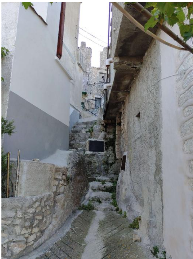
Foto C39 - LOTTO 3 - FABBRICATO - PROSPETTO SU VIA CASALE
