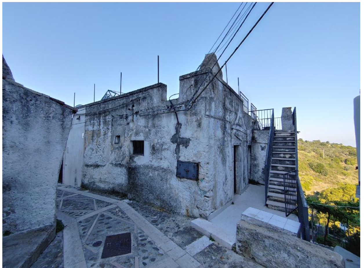
Foto C2 - LOTTO 1 - FABBRICATO - PROSPETTI SU VIA CASALE
