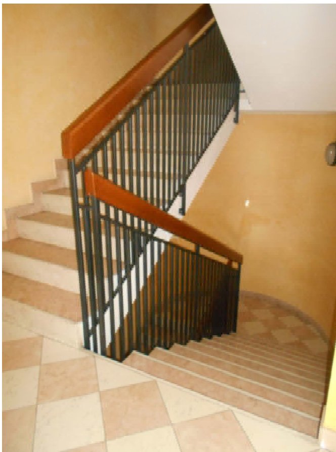
Foto 7: vano-scala condominiale, pianerottolo intermedio
