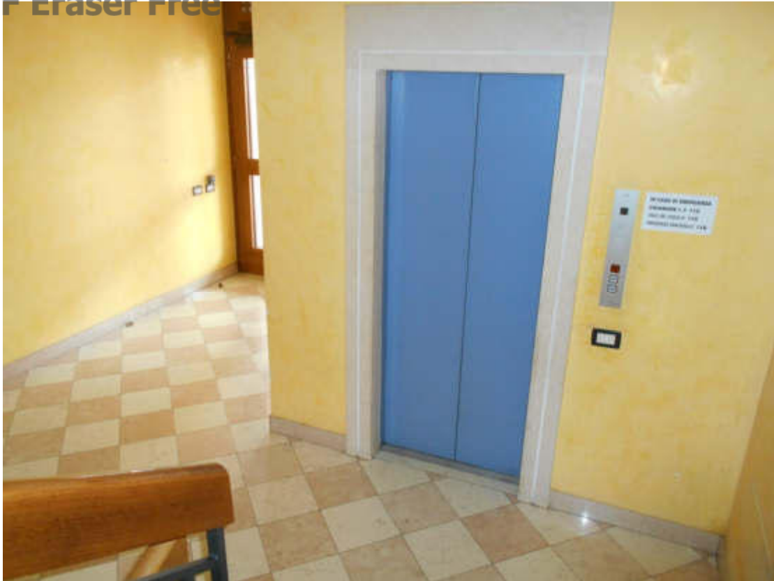
Foto 6: vano scala condominiale, piano terra
