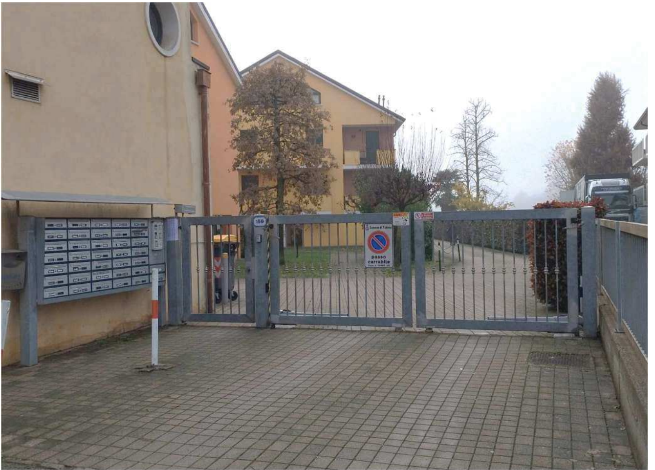
Veduta dell'ingresso pedonale e carroia
