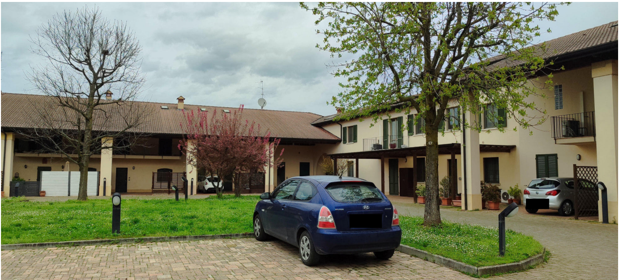
VISTA DELLA CORTE INTERNA DEL FABBRICATO
