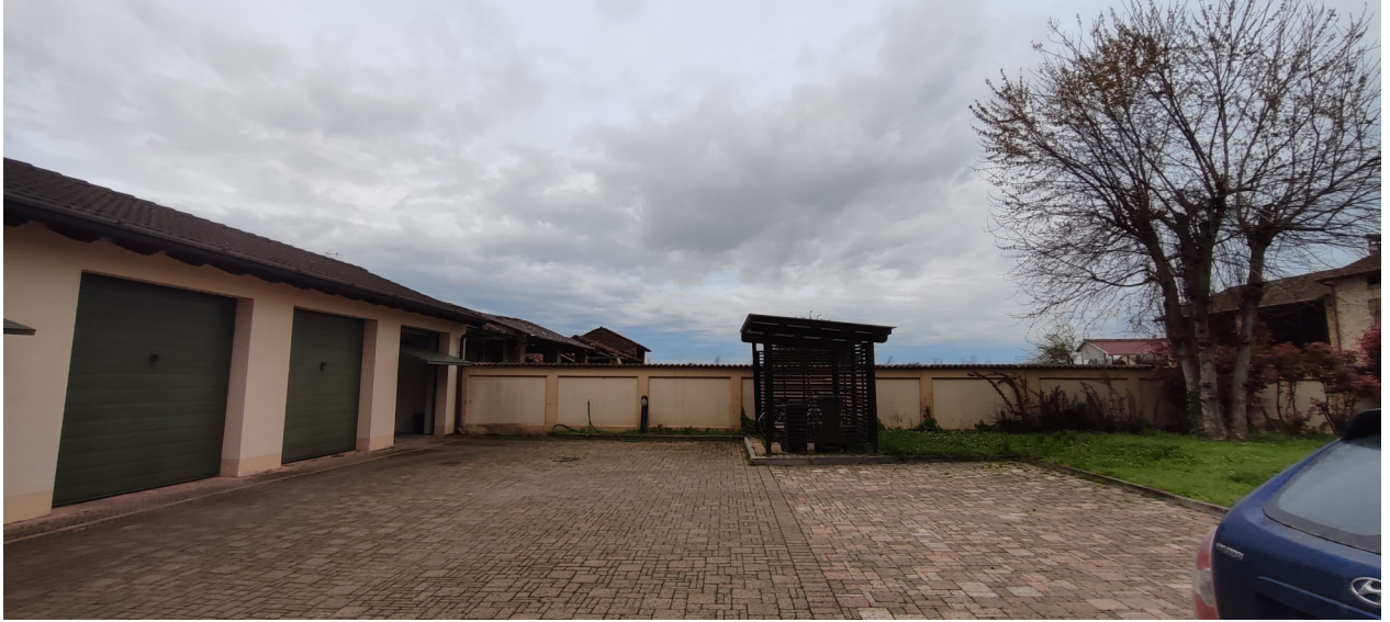
VISTA GENERALE DELLA CORTE INTERNA
