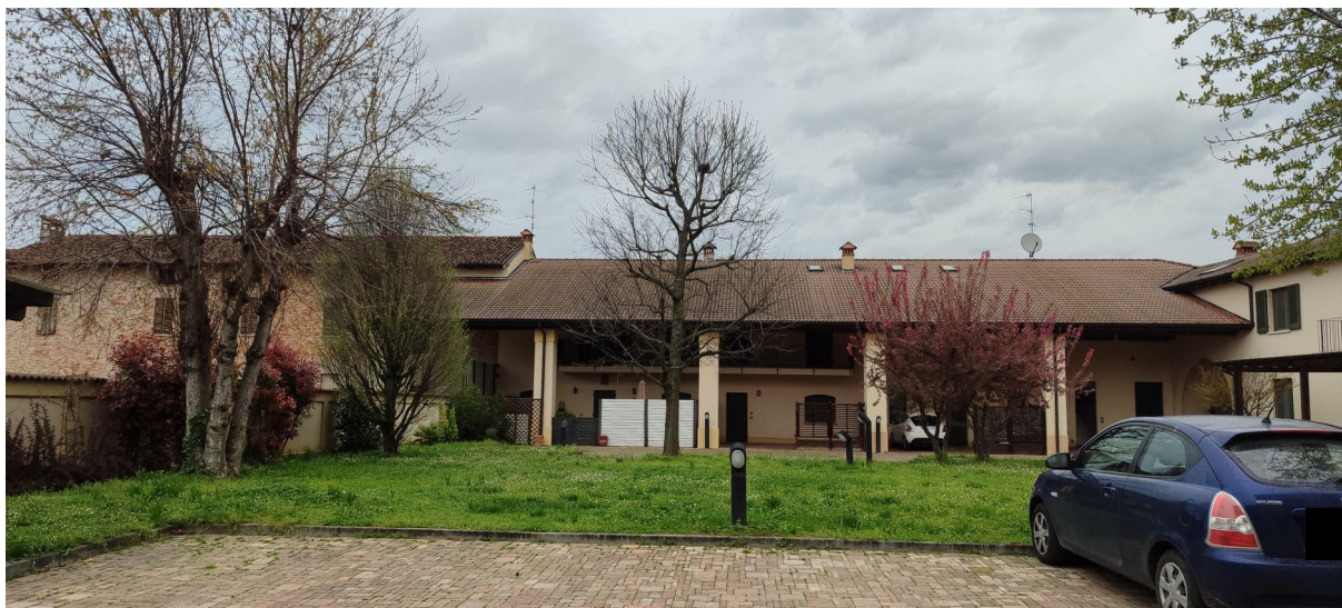
VISTA DELLA CORTE INTERNA DEL FABBRICATO
