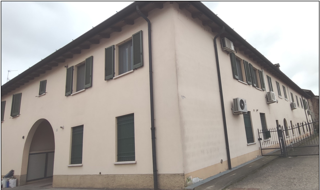
VISTA D'ANGOLO DEL FABBRICATO
