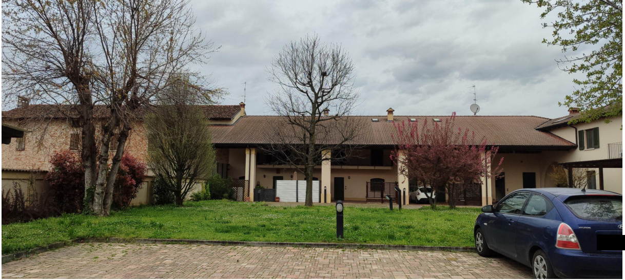
VISTA DELLA CORTE INTERNA DEL FABBRICATO
