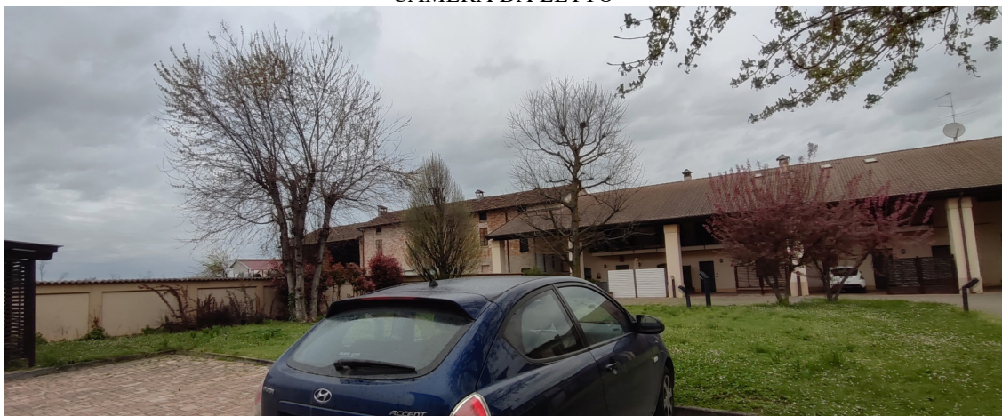
VISTA GENERALE DELLA CORTE INTERNA
