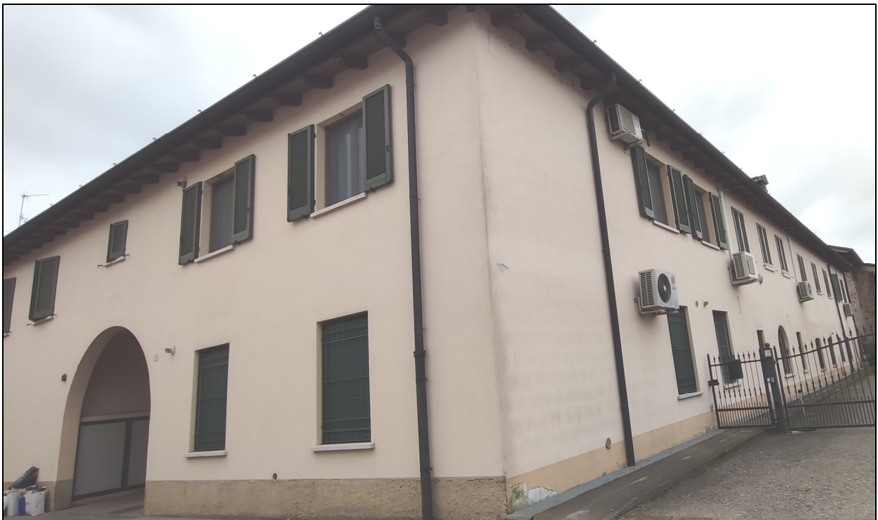
VISTA D'ANGOLO DEL FABBRICATO
