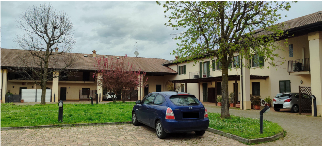
VISTA DELLA CORTE INTERNA DEL FABBRICATO
