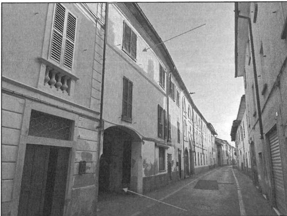
Foto edificio da Via Ferrari
