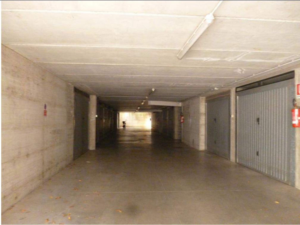
FOTO n° 9 : Corsia di manovra autorimesse.
