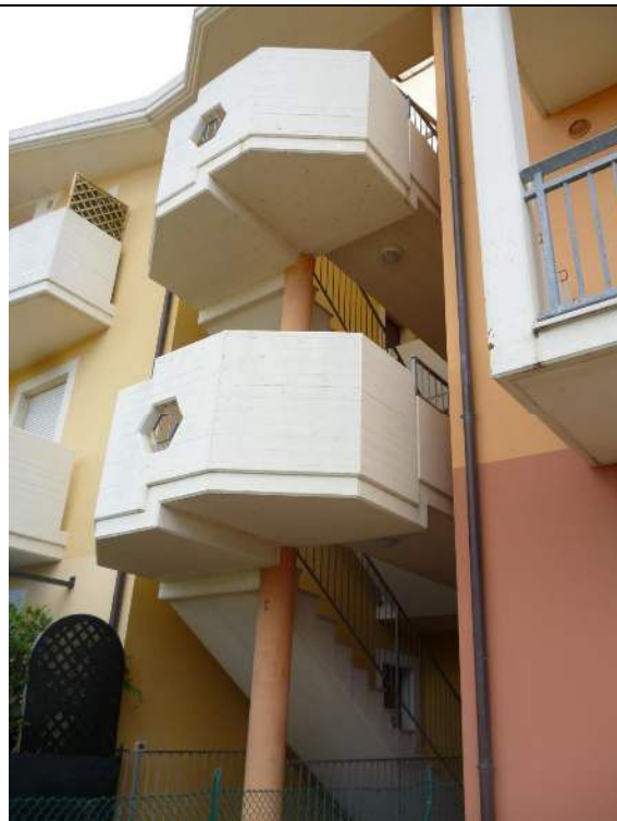
FOTO n° 4 : Vista scala di accesso esterna sub. 52.
