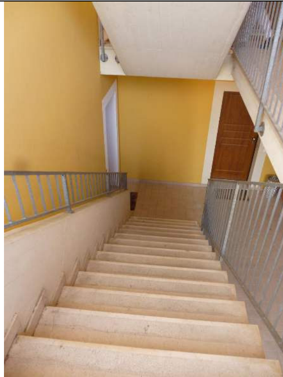
FOTO n° 5 : Vista scala esterna di accesso sub. 52.
