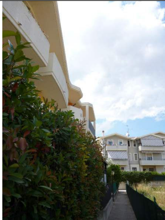
FOTO n° 3 : Vista retro-prospetto nord-est marciapiede sub. 50.
