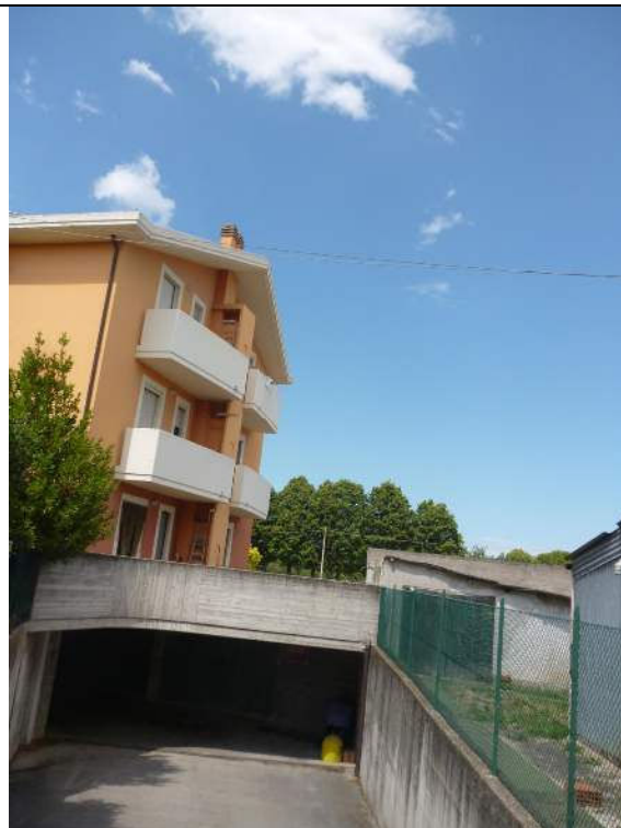
FOTO n° 6 : Rampa di accesso alle autorimesse.
