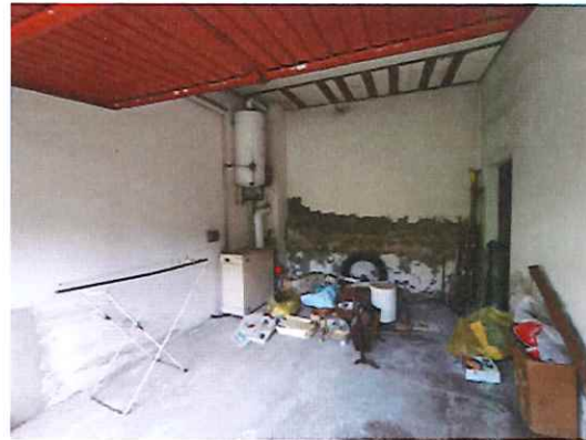
Foto 24) Part. interno – Rustico adiacente all'abitazione
