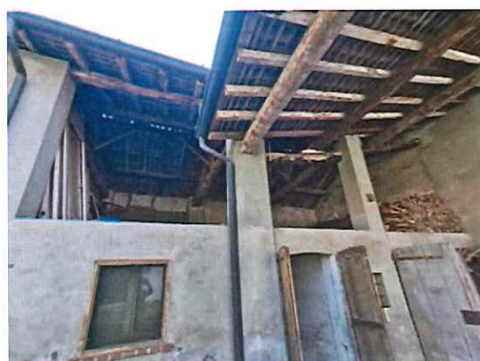
Foto 55) Part. esterno – Fronte rustico e porticato
