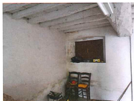
Foto 57) Part. interno – Locale accessorio (piano terra)
