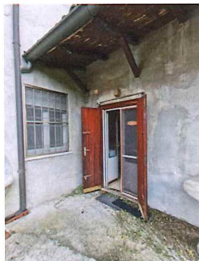
Foto 29) Part. ingresso cucina dal cortile
