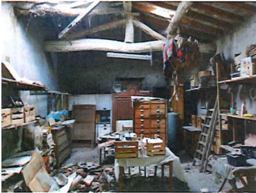
Foto 23) Part. interno – Rustico adiacente all'abitazione
