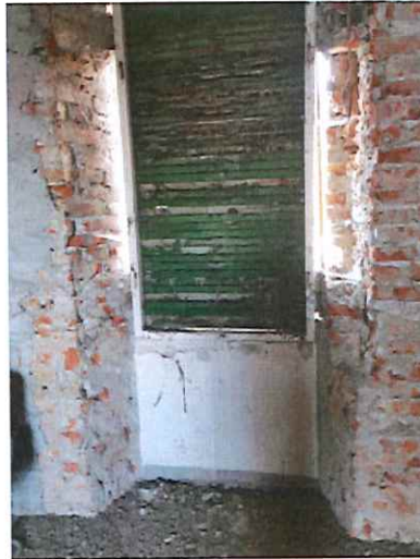
Foto 44) Part. interno – Chiusura provvisoria finestre
