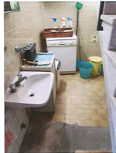
Foto 14) Part. interno – Disimpegno/Lavanderia
