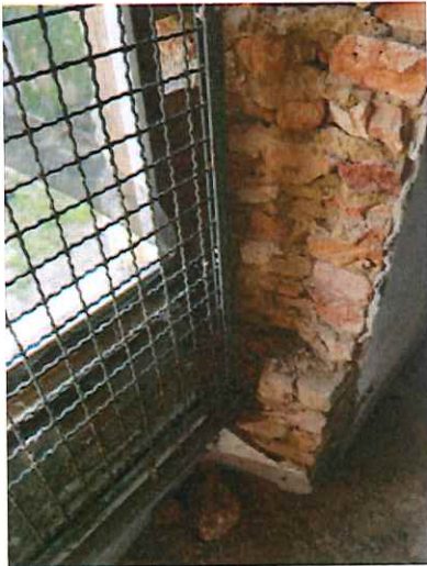
Foto 45) Part. interno – Muratura perimetrale
