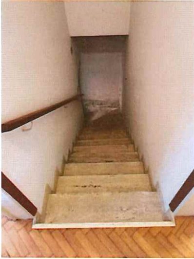
Foto 21) Part. interno – Scala (Primo piano)
