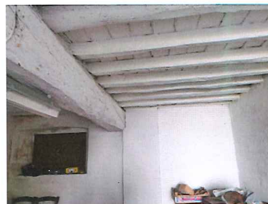
Foto 58) Part. interno – Locale accessorio (piano terra)
