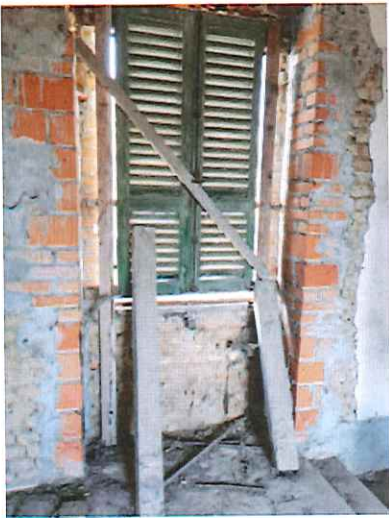
Foto 43) Part. interno – Chiusura provvisoria finestre
