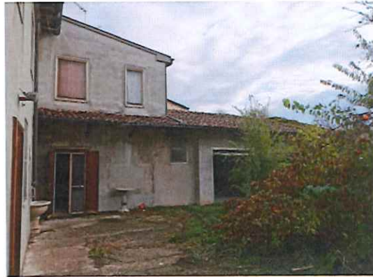
Foto 2) Fronte dal cortile interno
