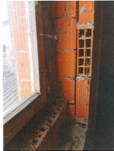
Foto 41) Part. interno – muratura perimetrale (primo piano)
