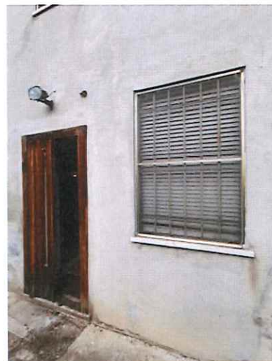
Foto 30) Part. ingresso abitazione dal cortile
