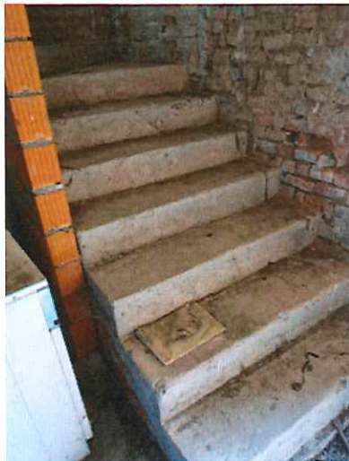
Foto 42) Part. interno – scala interna
