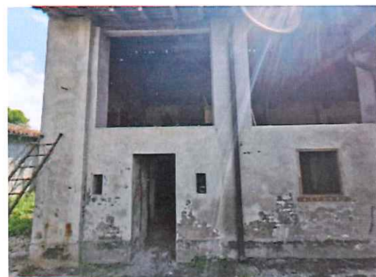
Foto 31) Part. fronte rustico dal cortile
