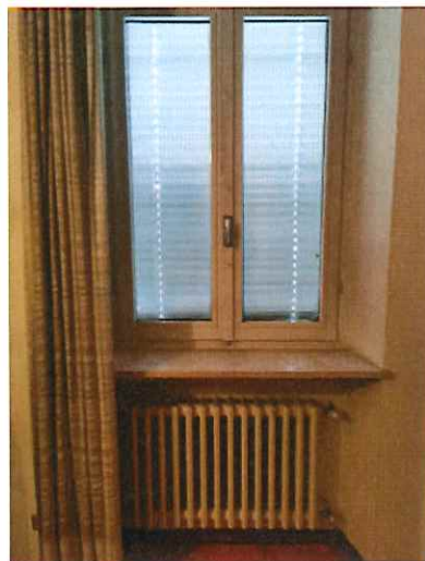
Foto 13) Part. interno – serramento
