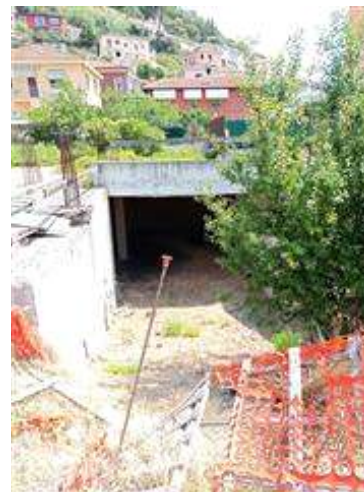
Particolare dell'interrato del fabbricato E6
