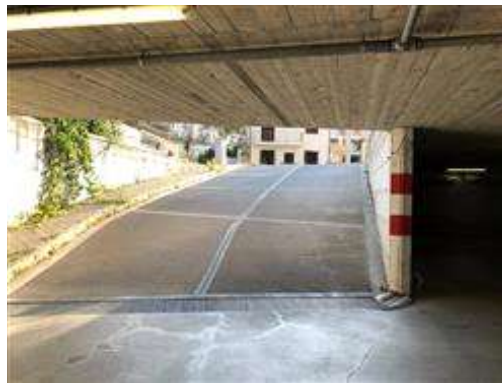
La rampa di accesso carrabile all'autorimessa interrata vista dall'interno
