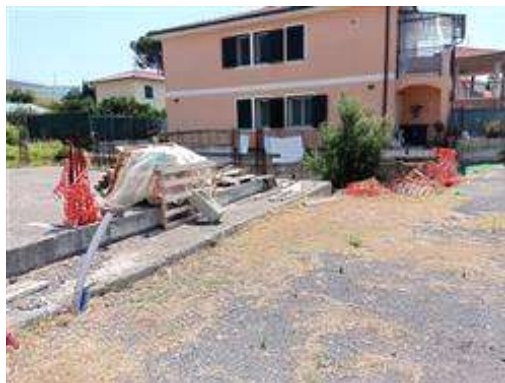
Particolare dell'interrato del fabbricato E6
