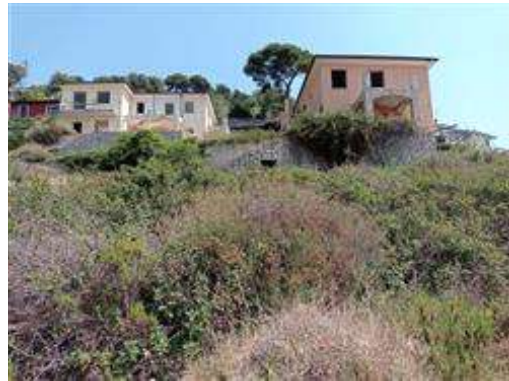
Particolare dei fabbricati C16 e G17 ripresi dai terreni a valle
