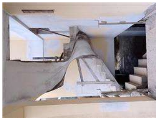
Particolare del vano scala esterno del fabbricato C16
