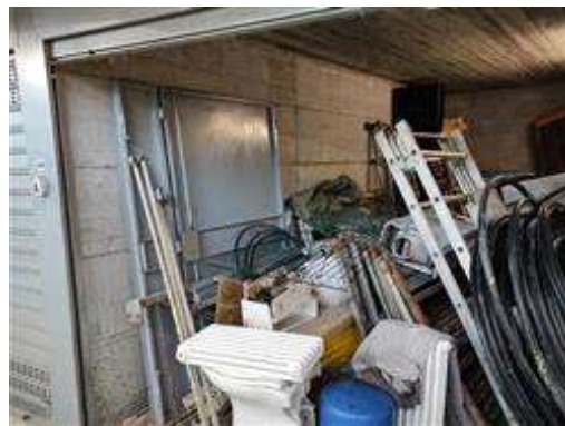
Particolare del box auto
