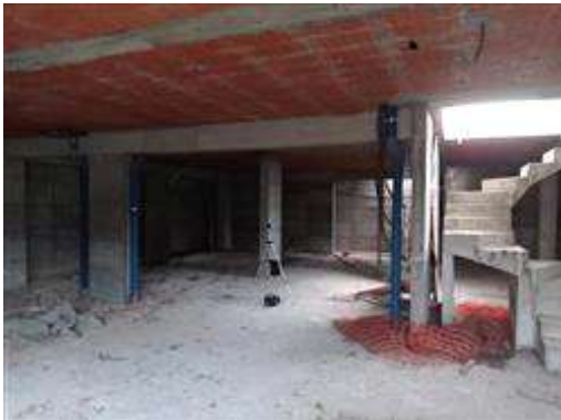
Particolare del piano interrato del fabbricato C16
