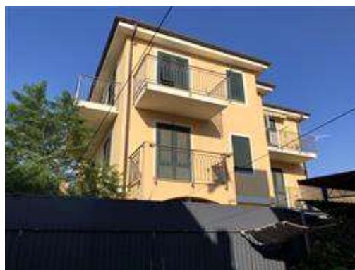
Particolare del retro della Palazzina F11 lungo il quale si attesta la particella 1372
