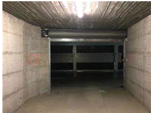
Particolare del box auto
