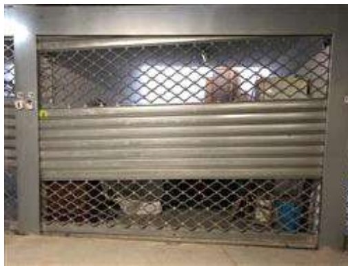
Particolare dell'accesso al box auto
