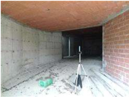
Particolare del piano interrato del fabbricato G17
