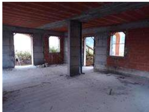
Particolare del piano terra del fabbricato G17
