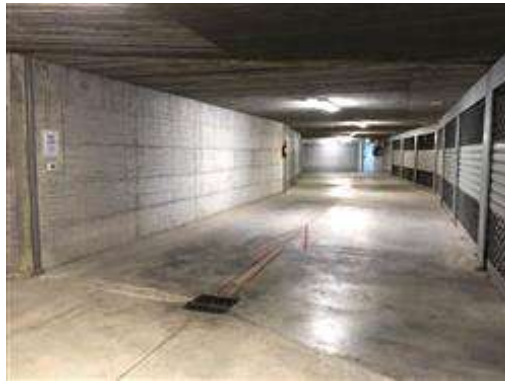
Particolare della corsia interna dell'autorimessa
