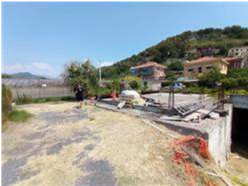
Particolare dell'interrato del fabbricato E6
