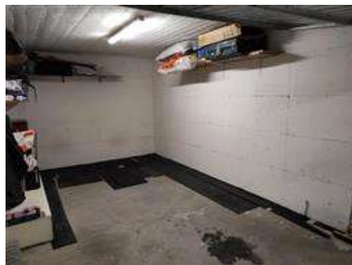
Particolare del box auto
