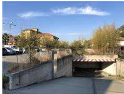
La rampa di accesso carrabile all'autorimessa interrata vista dall'esterno
