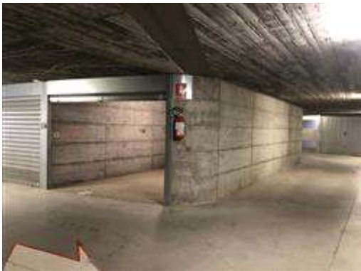
Particolare del box auto
