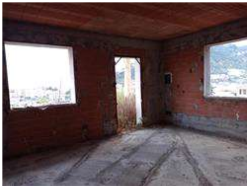
Particolare del piano terra del fabbricato C16
