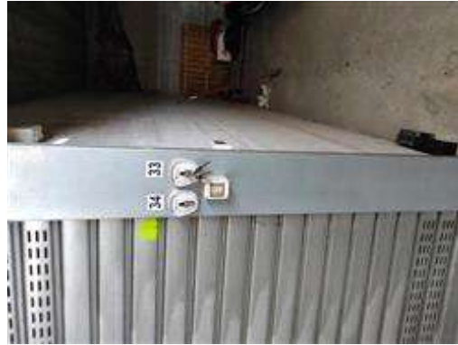
Particolare del box auto
