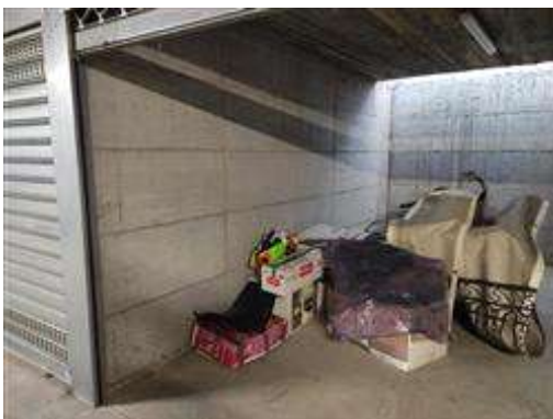
Particolare del box auto
