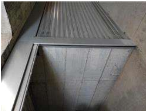
Particolare del box auto
