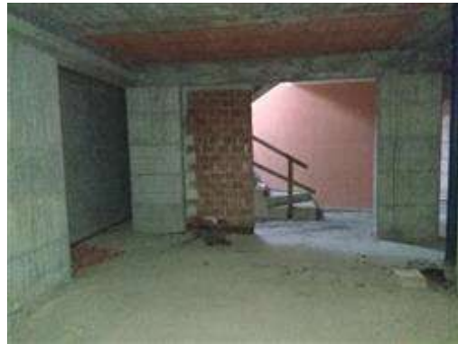
Particolare del piano interrato del fabbricato G17
