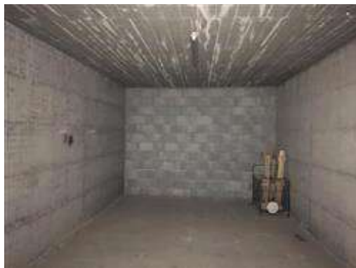
Particolare del box auto
