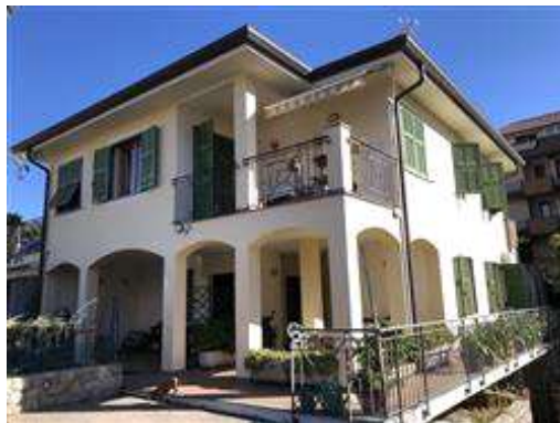
Particolare dell'edificio plurifamigliare in cui si colloca l'u.i. in oggetto
