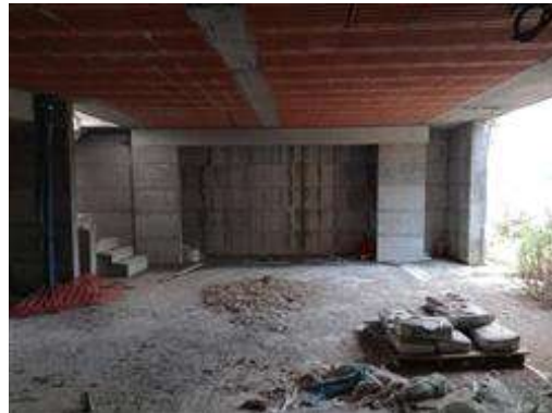
Particolare del piano interrato del fabbricato C16
