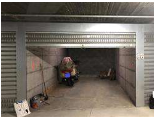
Particolare del box auto
