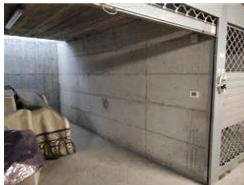
Particolare del box auto
