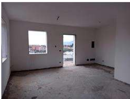
Particolare del piano primo del fabbricato C16
