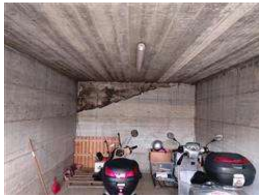
Particolare del box auto
