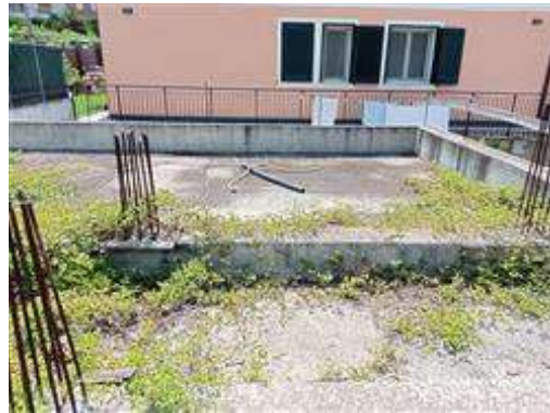
Particolare dell'interrato del fabbricato E6
