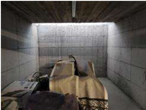
Particolare del box auto
