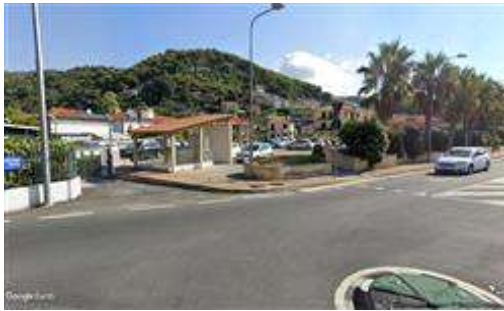
Particolare del parcheggio pubblico da via San Rocco: è visibile uno dei due corpi scala di accesso pedonale
