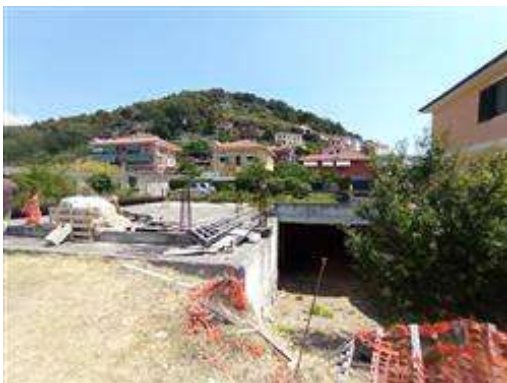
Particolare dell'interrato del fabbricato E6
