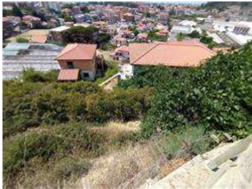
Particolare dei fabbricati C16 e G17 ripresi dai terreni a monte
