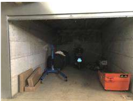
Particolare del box auto
