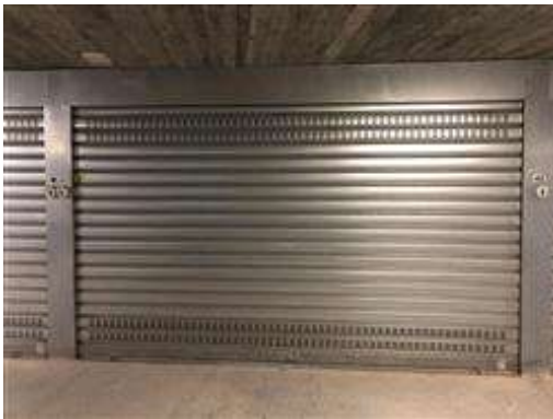
Particolare del box auto
