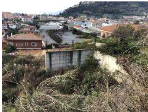
Particolare della struttura in c.a. corrispondente a parte dell'interrato del fabbricato C14
