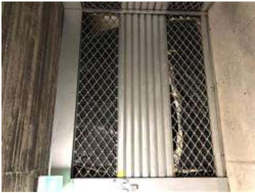
Particolare della serranda del box
