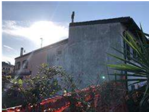
Particolare dell'immobile da nord
