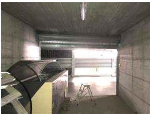
Particolare del box auto
