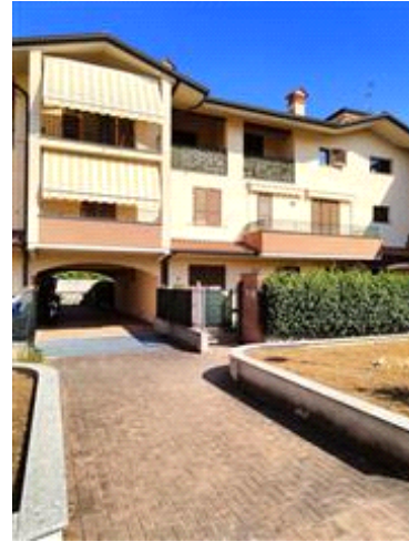
Vista corte interna
