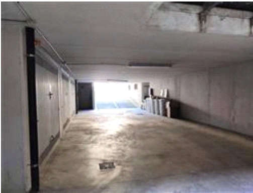
Vista generale piano interrato
