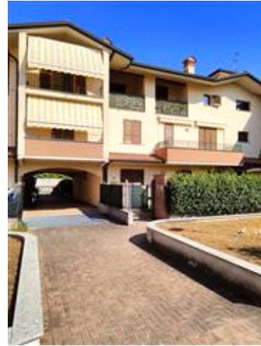
Vista corte interna
