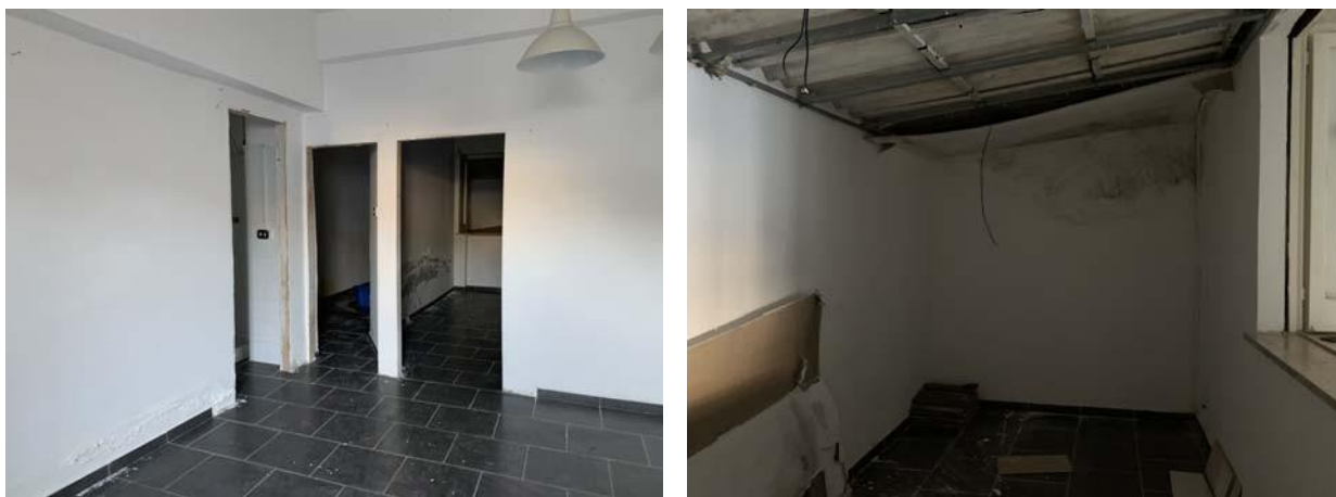
Vista degli accessi ai due ambienti posteriori e del volume cieco rimasto definito dalla realizzazione di una parete e una tettoia su quota parte dell’originaria area esterna pertinenziale (corte)
