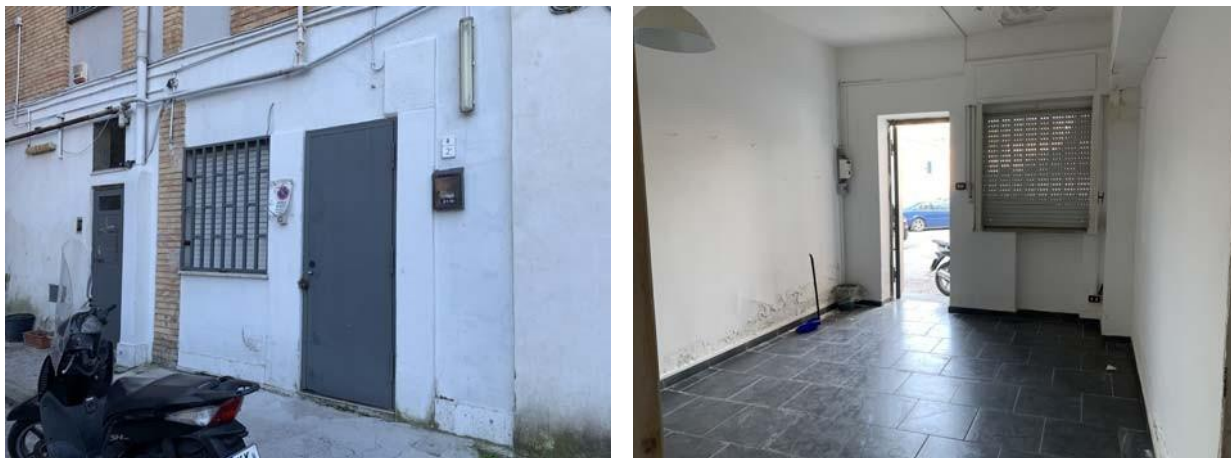
Vista della porta di accesso e dell’ambiente posto all’ingresso dell’unità
