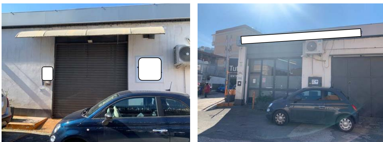
Vista dei due accessi al locale
