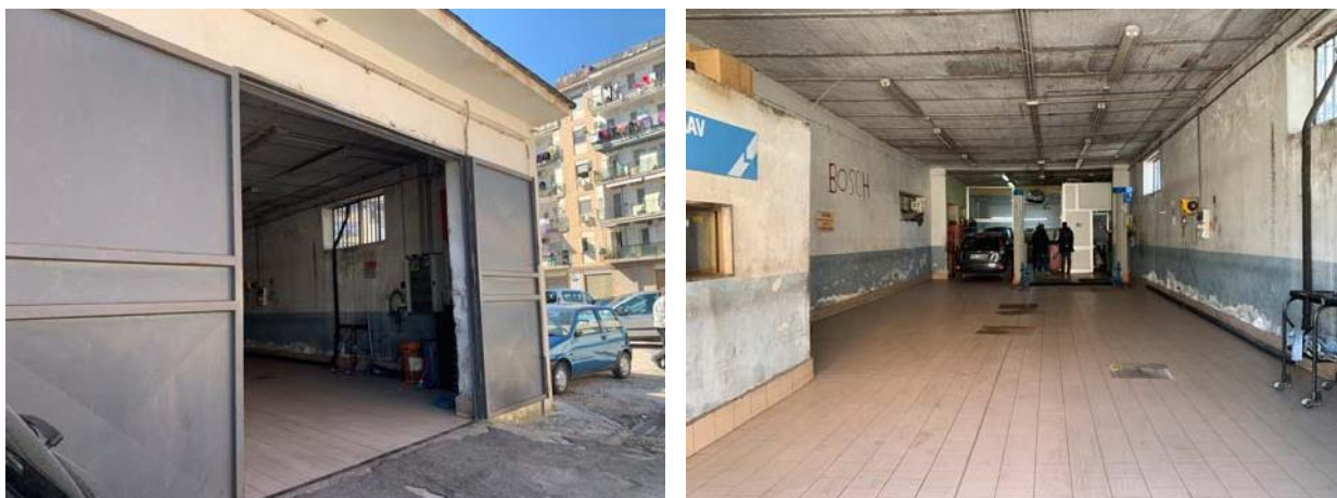
Vista dell'accesso al locale e particolare interno dello stesso
