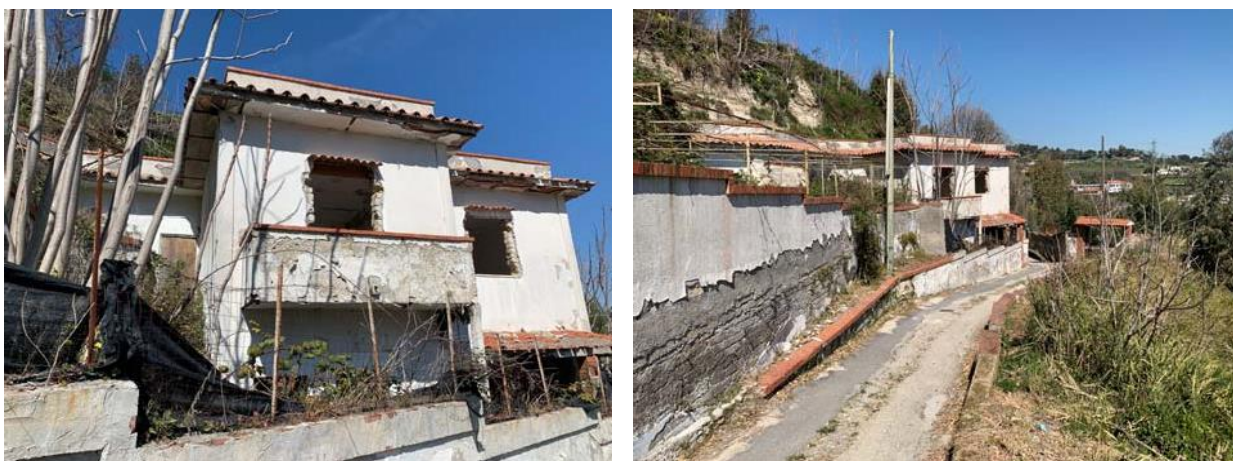
Particolari dello stato attuale del manufatto di due livelli insistente sulla p.lla 619
