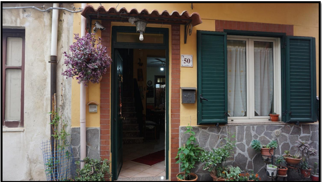
Accesso all'immobile oggetto di perizia – Via Idria ,50
