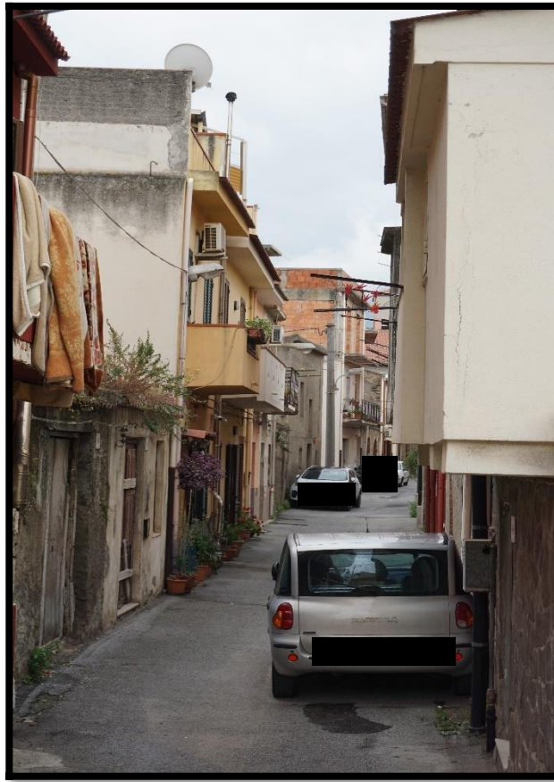
Vista esterna dell'immobile oggetto di perizia – Via Idria ,50
