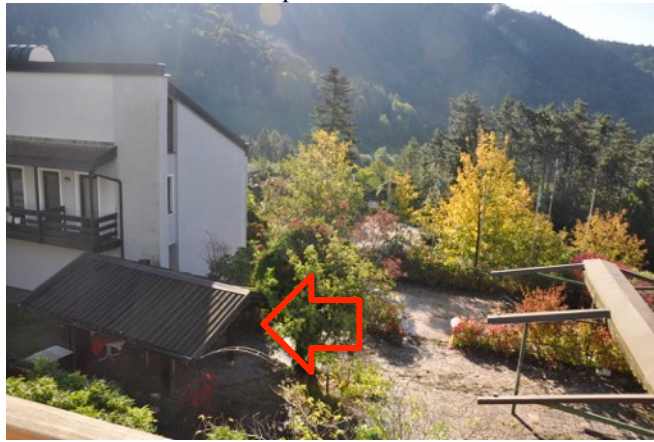
Tettoia in p.f. 1115/6.
