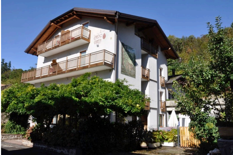
Corpo di fabbrica principale – zona ingresso
