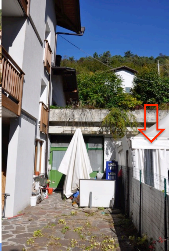
Andito est sullo sfondo il serramento zona cucina – a dx altra proprietà
