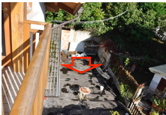
Terrazzo/copertura primo piano verso est
