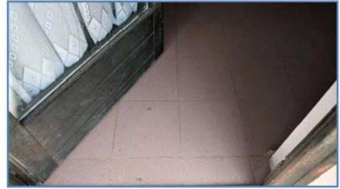
particolare serramenti esterni
