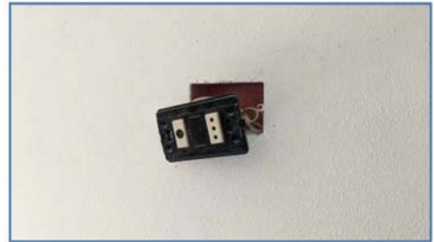
particolare impianto elettrico manomesso in alcuni punti
