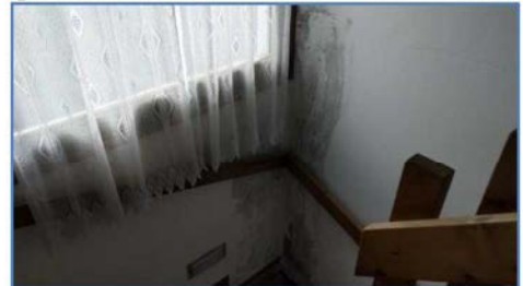
porzione intonaco vano scale deteriorato
