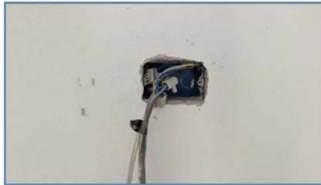
particolare impianto elettrico manomesso in alcuni punti
