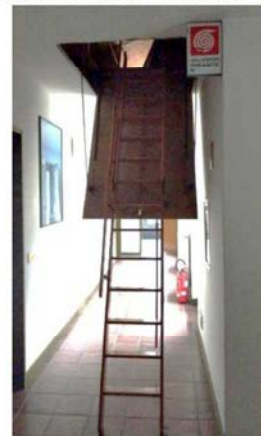
scala retrattile di accesso al sottotetto
