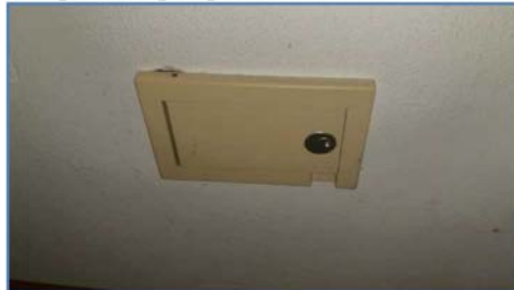
presa aspirapolvere centralizzato
