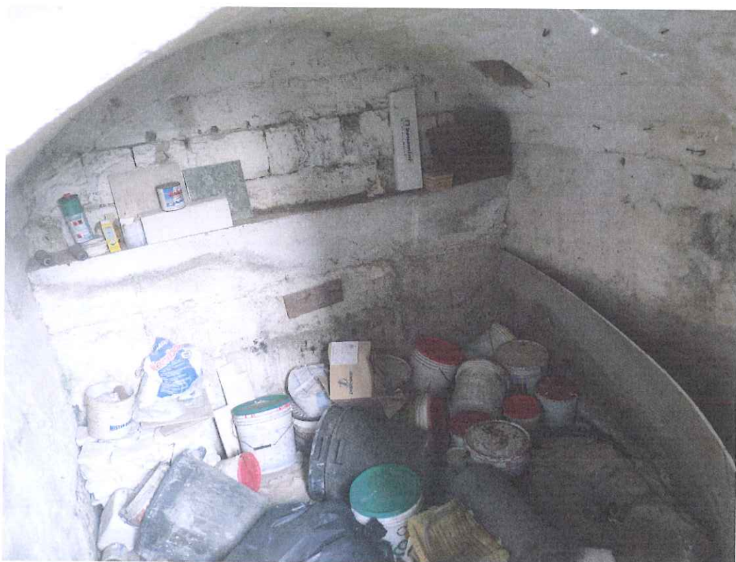
Foto 14 - vano (piano cantina)
