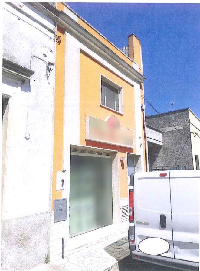
Foto 1 - prospetto su via della Luce – Veglie (LE)
