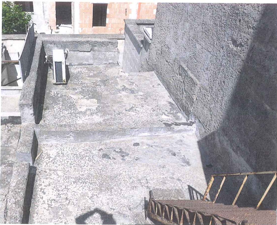
Foto 13 - terrazza (lastricato solare)
