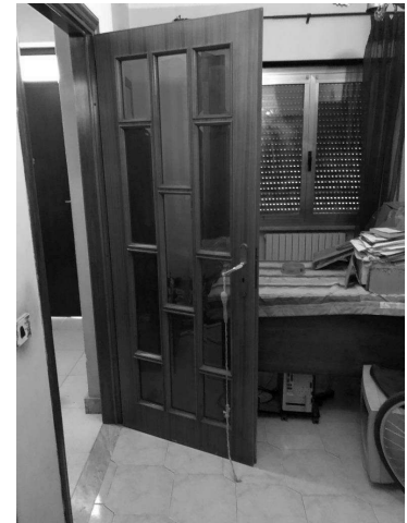
vano pluriuso p.Terra Particolare porta e infissi
