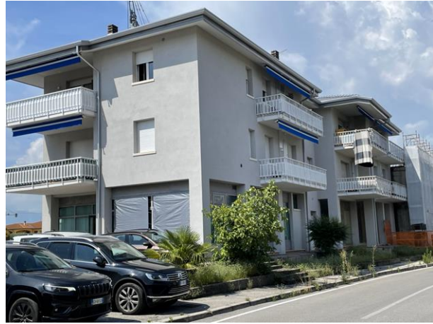
veduta retro fabbricato su Via Cavour
