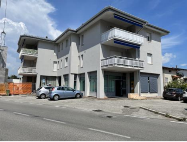
veduta fabbricato fronte strada Via G. Pascoli
