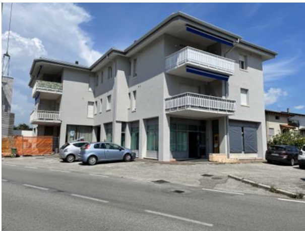
veduta fabbricato fronte strada Via G. Pascoli
