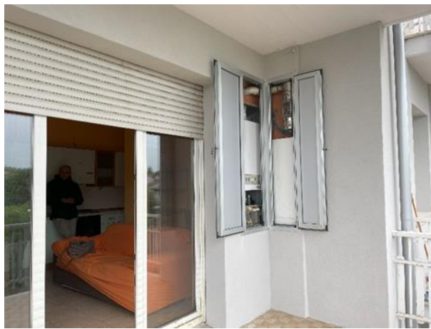
caldaia esterna
