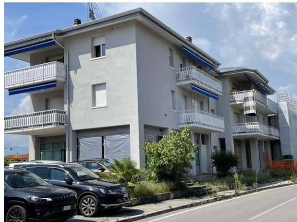
veduta retro fabbricato su Via Cavour
