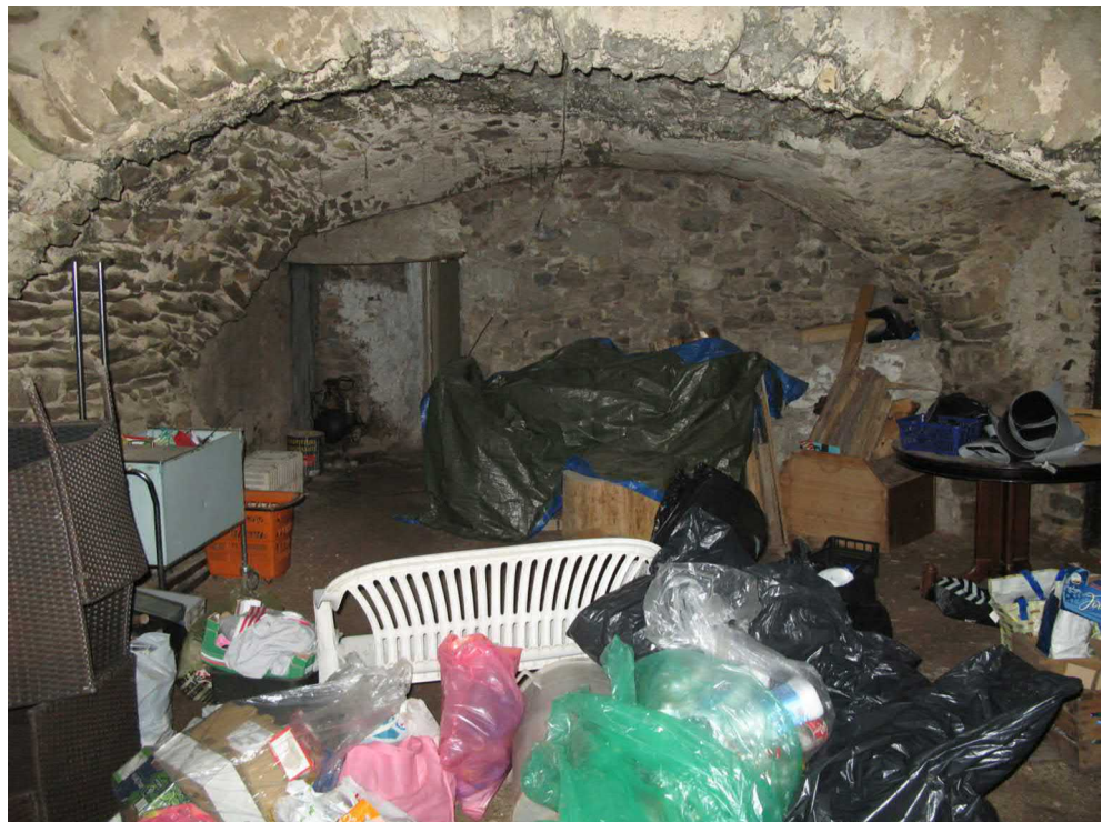
Foto n° 4: Piano terra: portico.
