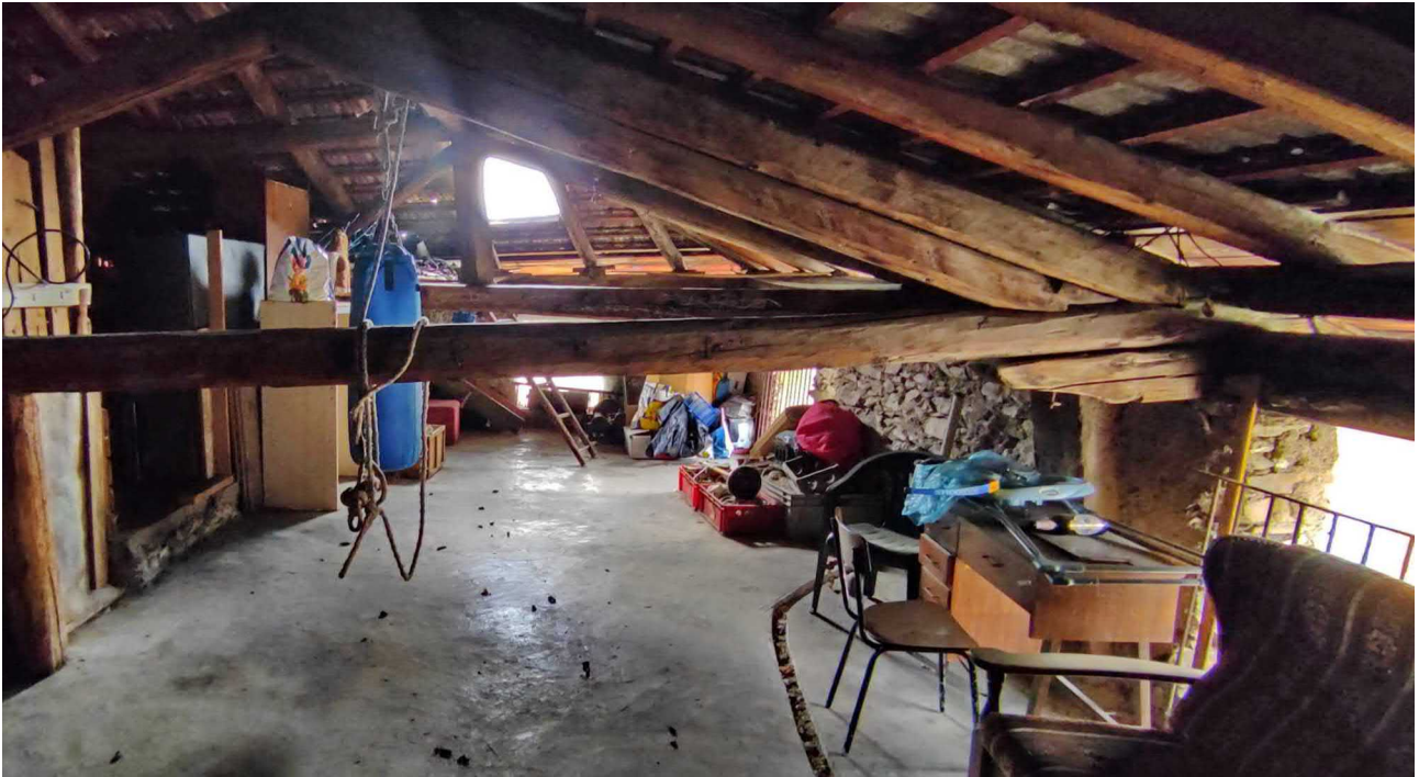
Foto n° 17: Piano terzo: soffitta.
