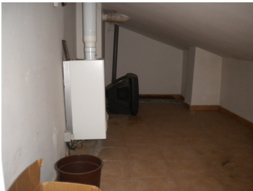
Foto 14 -Interni zona centrale
