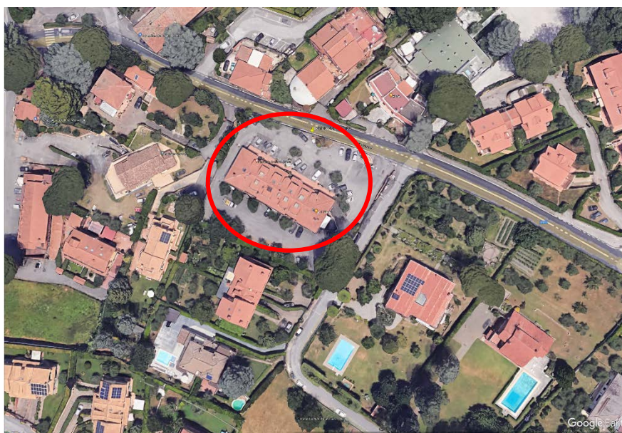
Foto B- ripresa satellitare edificio
