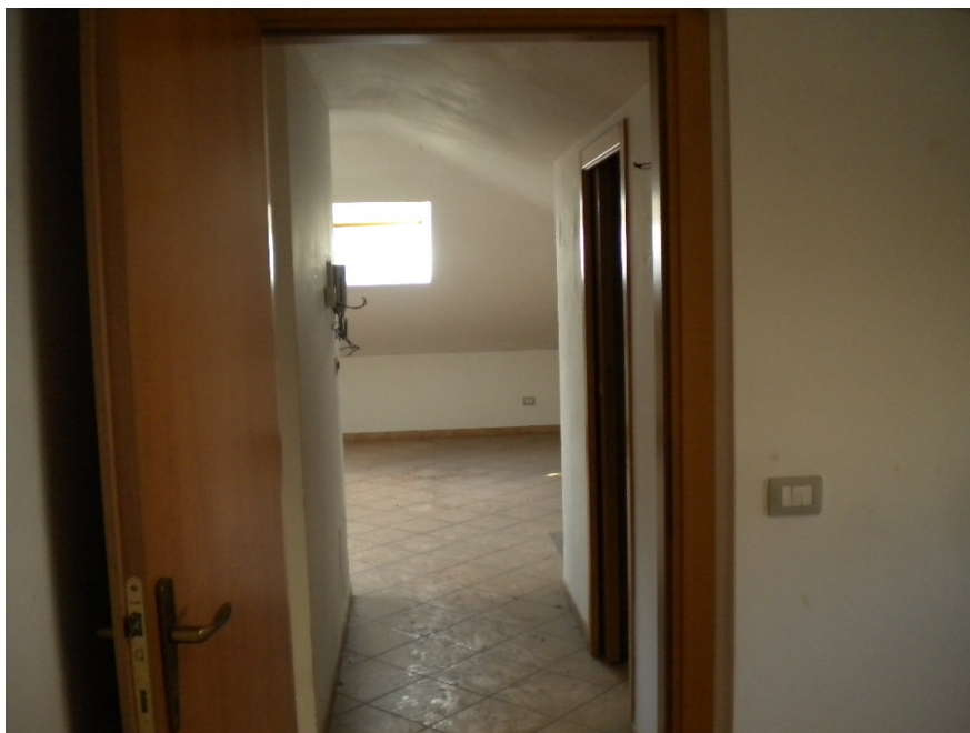
Foto 21 - Interni zona centrale
