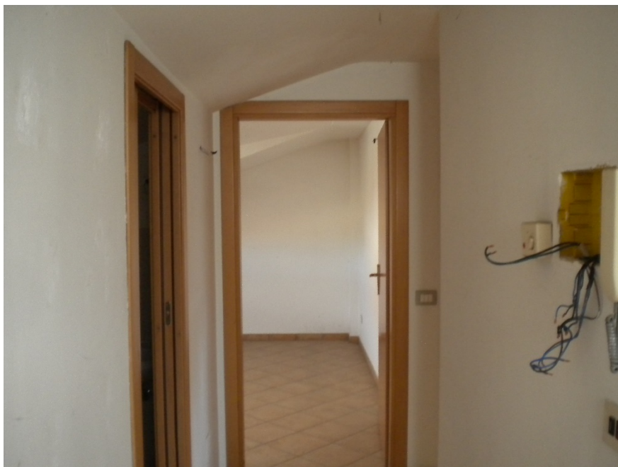
Foto 15 -Interni zona centrale
