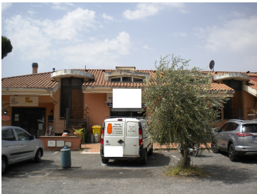
Foto 3- Prospetto principale zona centrale
