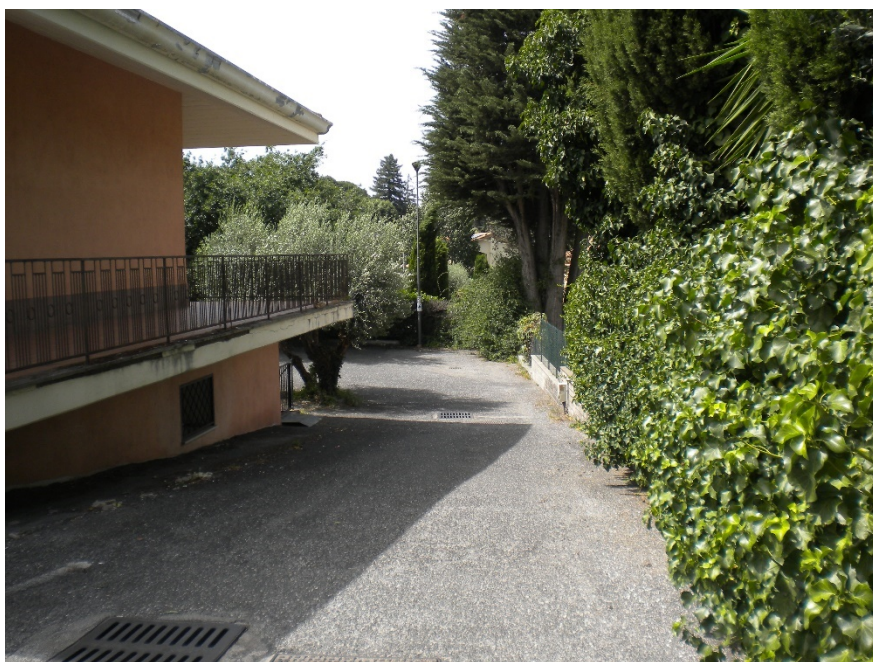
Foto 6-Rampa di accesso area retrostante
