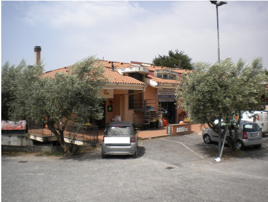
Foto 1- Panoramica edificio da area antistante, lato sinistro
