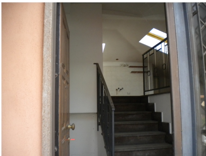
Foto 10 -Apertura porta ingresso a mezzo fabbro
