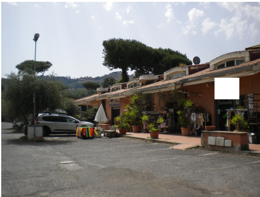
Foto 2- Panoramica altra angolazione lato destro.
