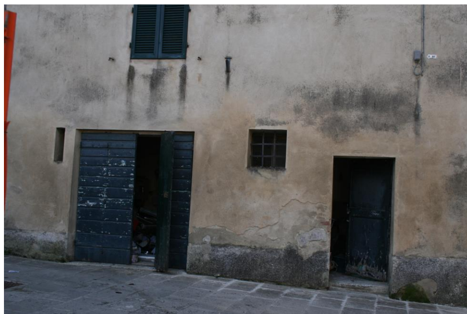
Veduta del portone di accesso al garage P.za del Grano
