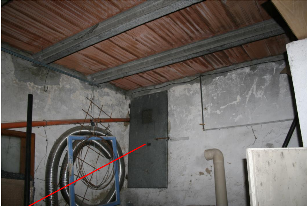
Veduta del soffitto del locale sgombero
