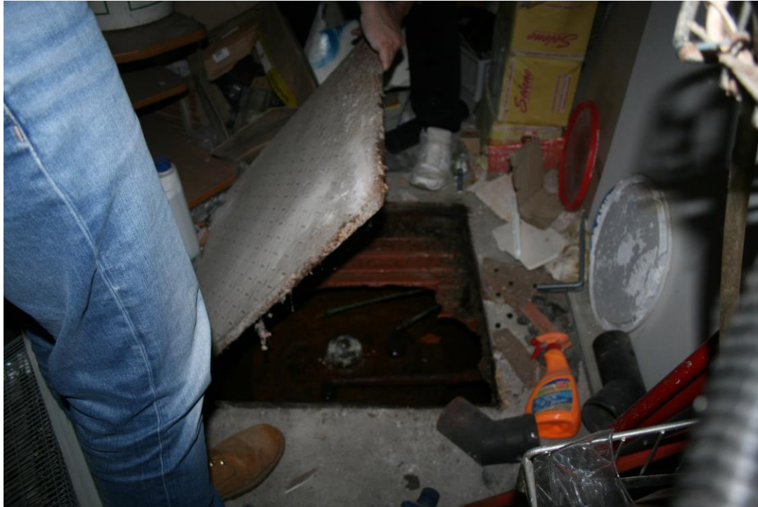
Veduta degli interni dei locali sgomberi (deposito gasolio interrato)
