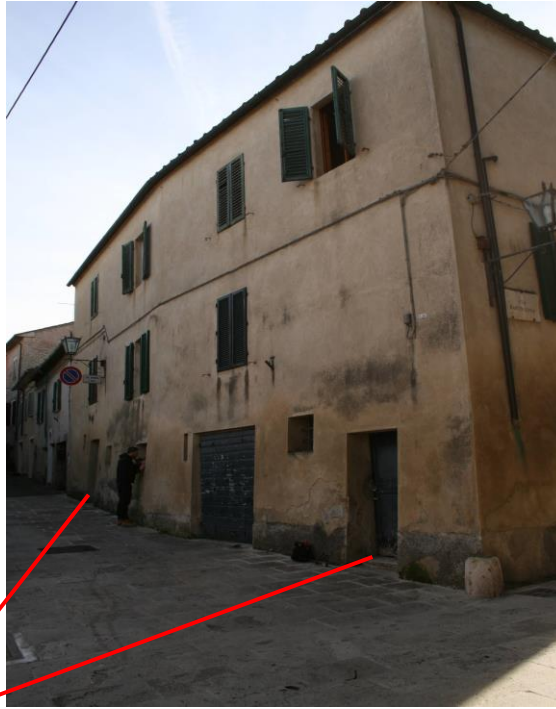
Veduta degli ingressi di accesso agli sgomberi
