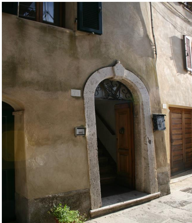
Portone ingresso da Via Bartolenga n. 24
