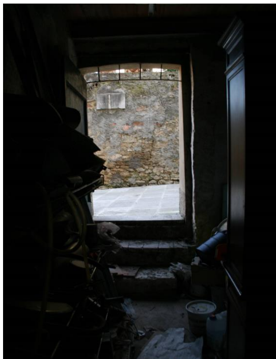
Veduta interna della porta di accesso al locale sgombero da via Santa Maria
