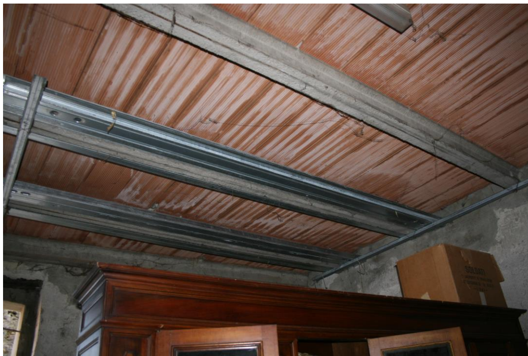
Veduta del soffitto del locale sgombero
