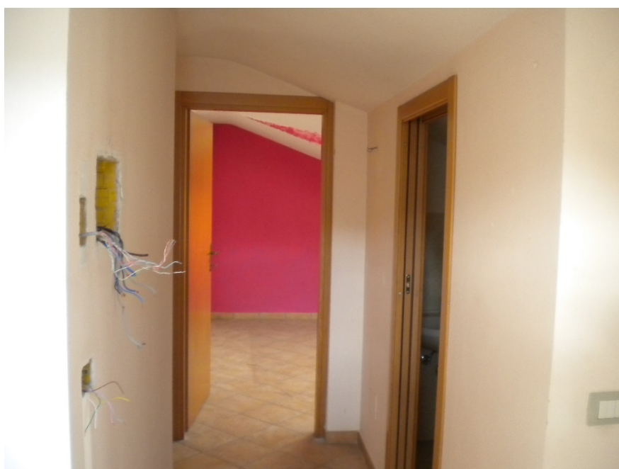
Foto 14 -Interni zona centrale
