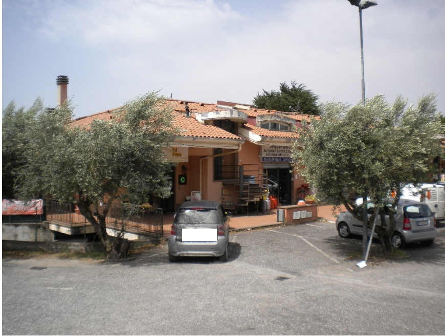
Foto 1- Panoramica edificio da area antistante, lato sinistro
