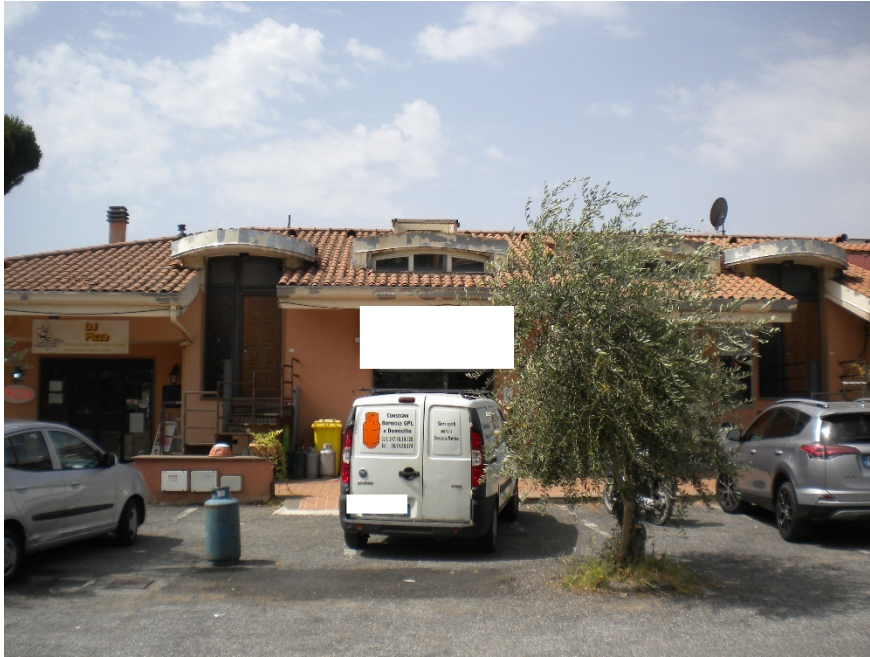
Foto 3- Prospetto principale zona centrale
