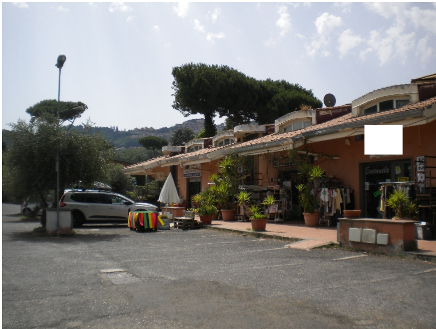
Foto 2- Panoramica altra angolazione lato destro.
