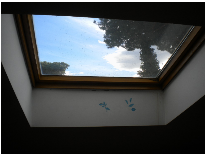
Foto 20 -Abbaino zona ingresso – f. 11
