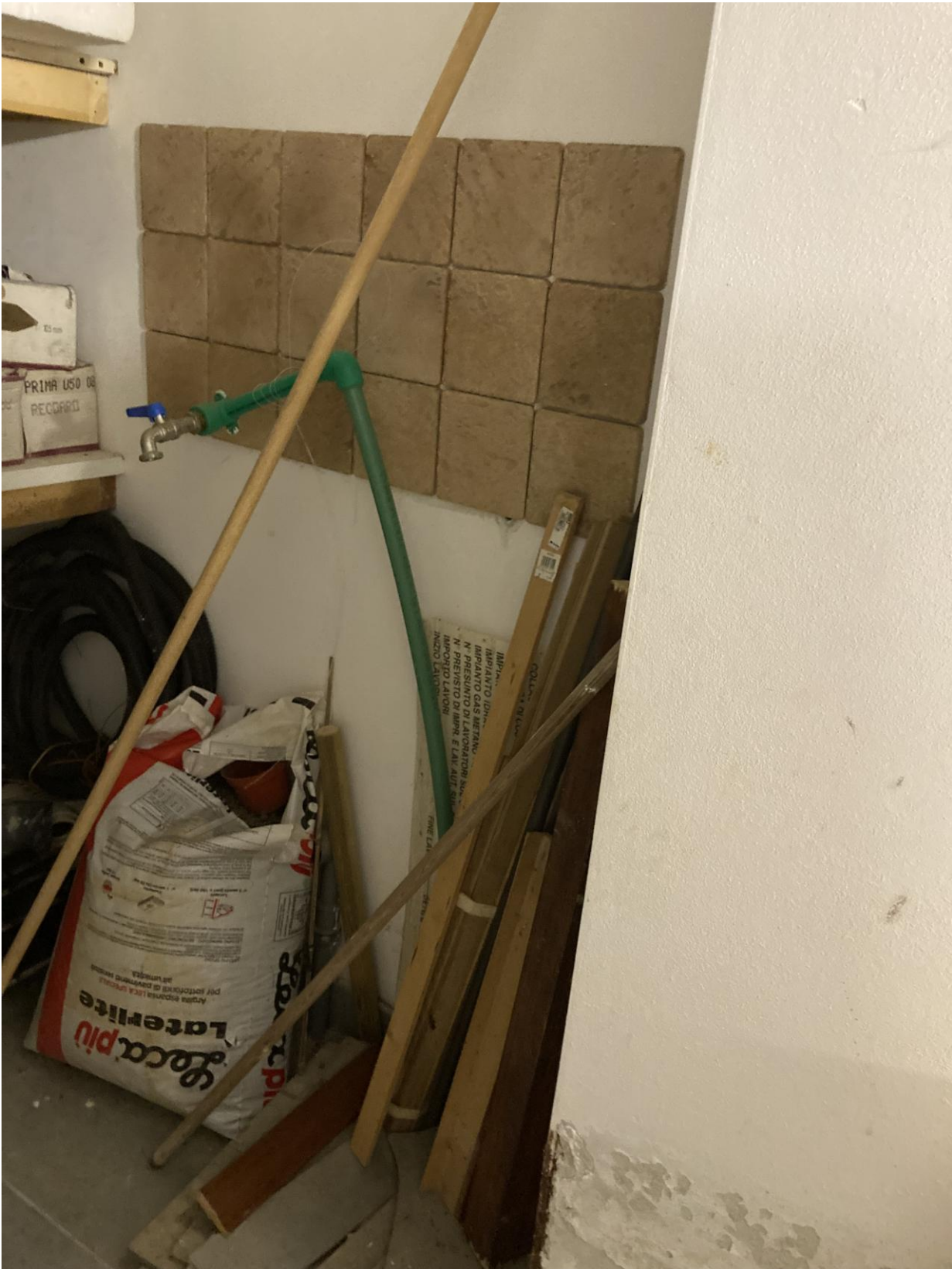
FOTO 27– PARTICOLARE PREDISPOSIZIONE ADDUZIONE ACQUA ALL'INTERNO DEL GARAGE
