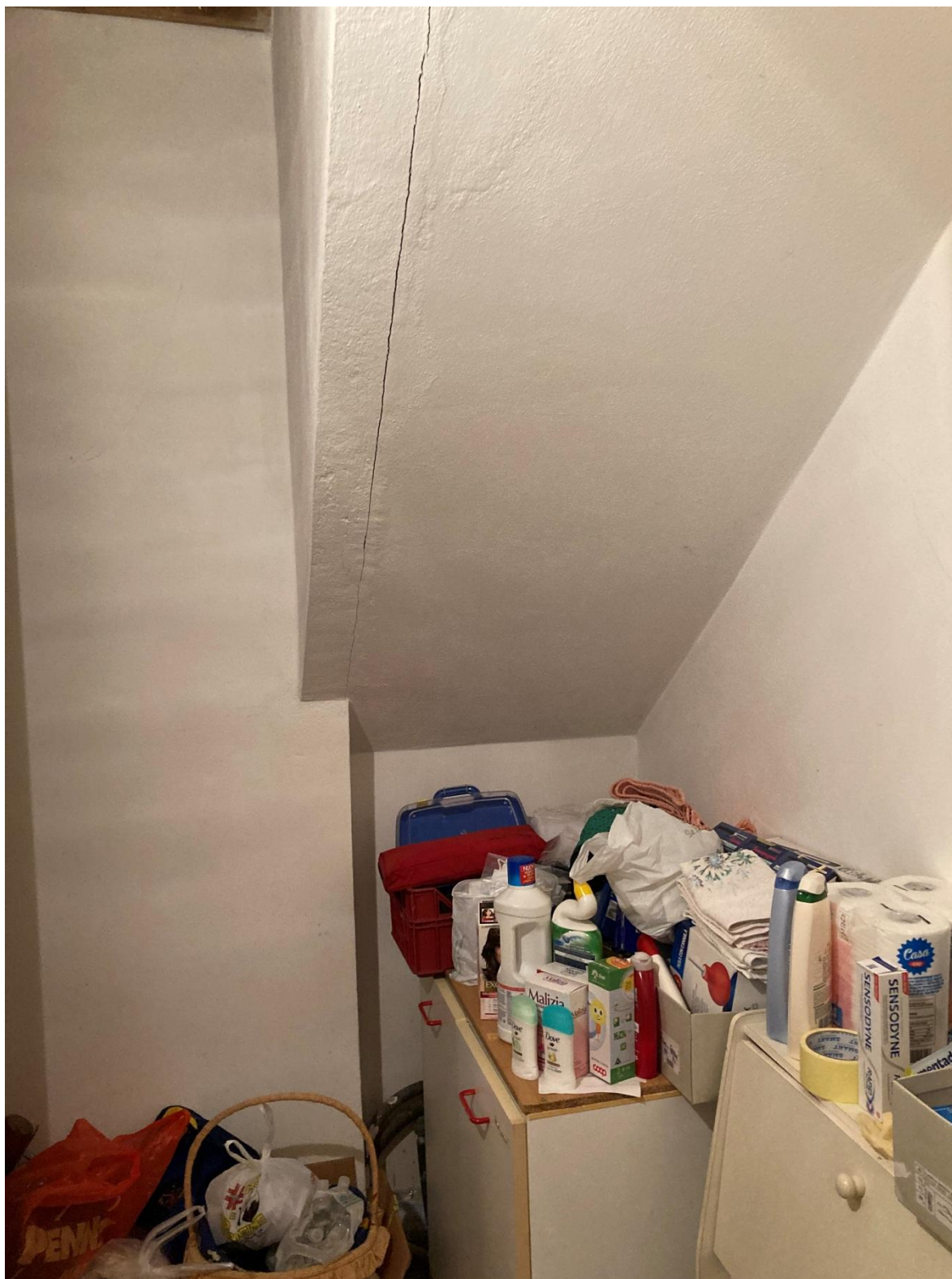
FOTO 13– VISTA DEL RIPOSTIGLIOAL PIANO PRIMO
