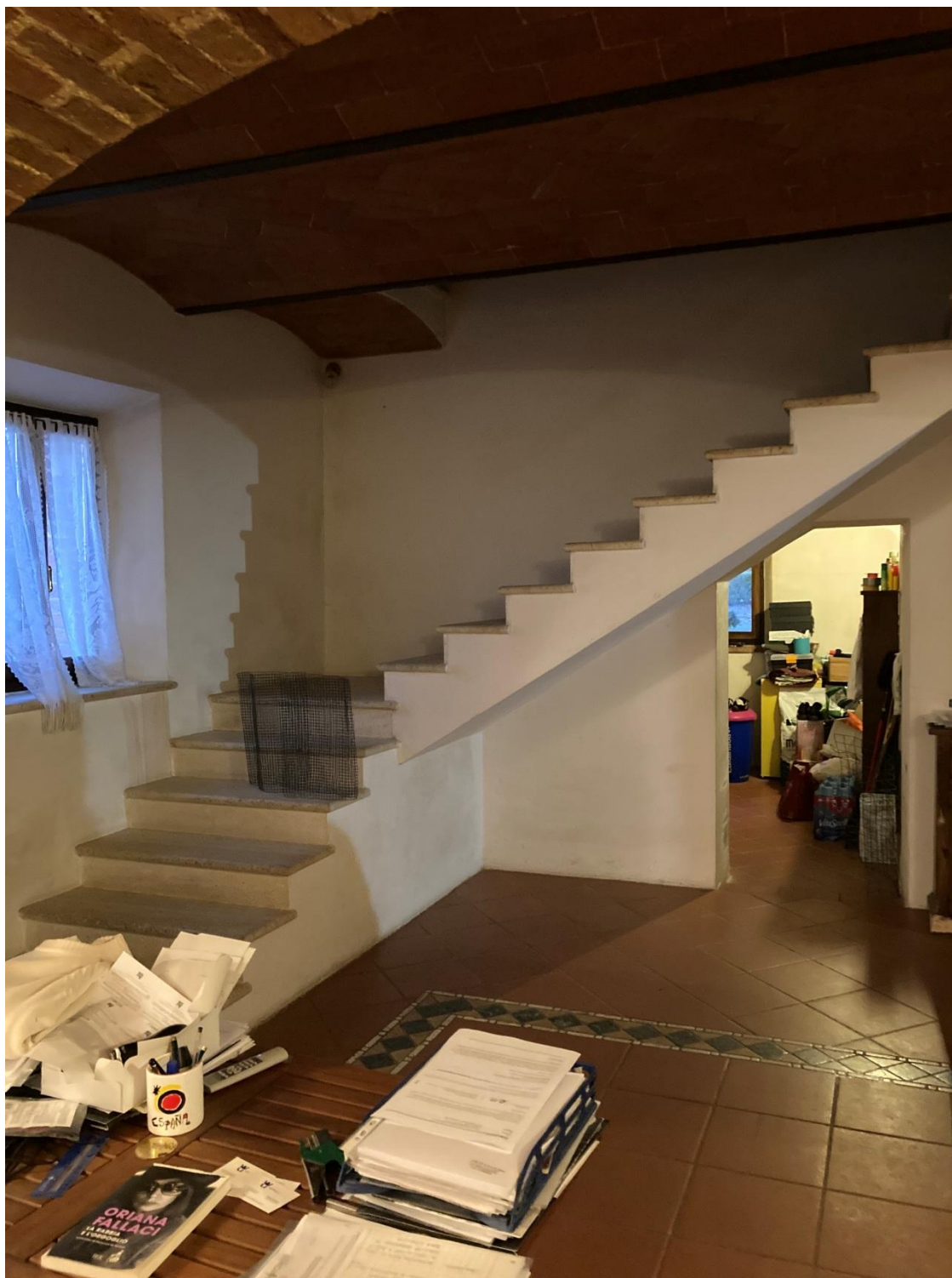
FOTO 5– VISTA DELLA SCALA DI COLLEGAMENTO
