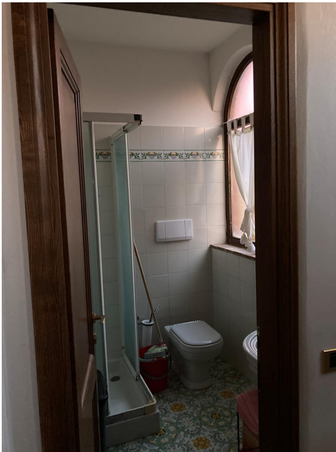
FOTO 8– VISTA DEL BAGNO AL PIANO TERRA
