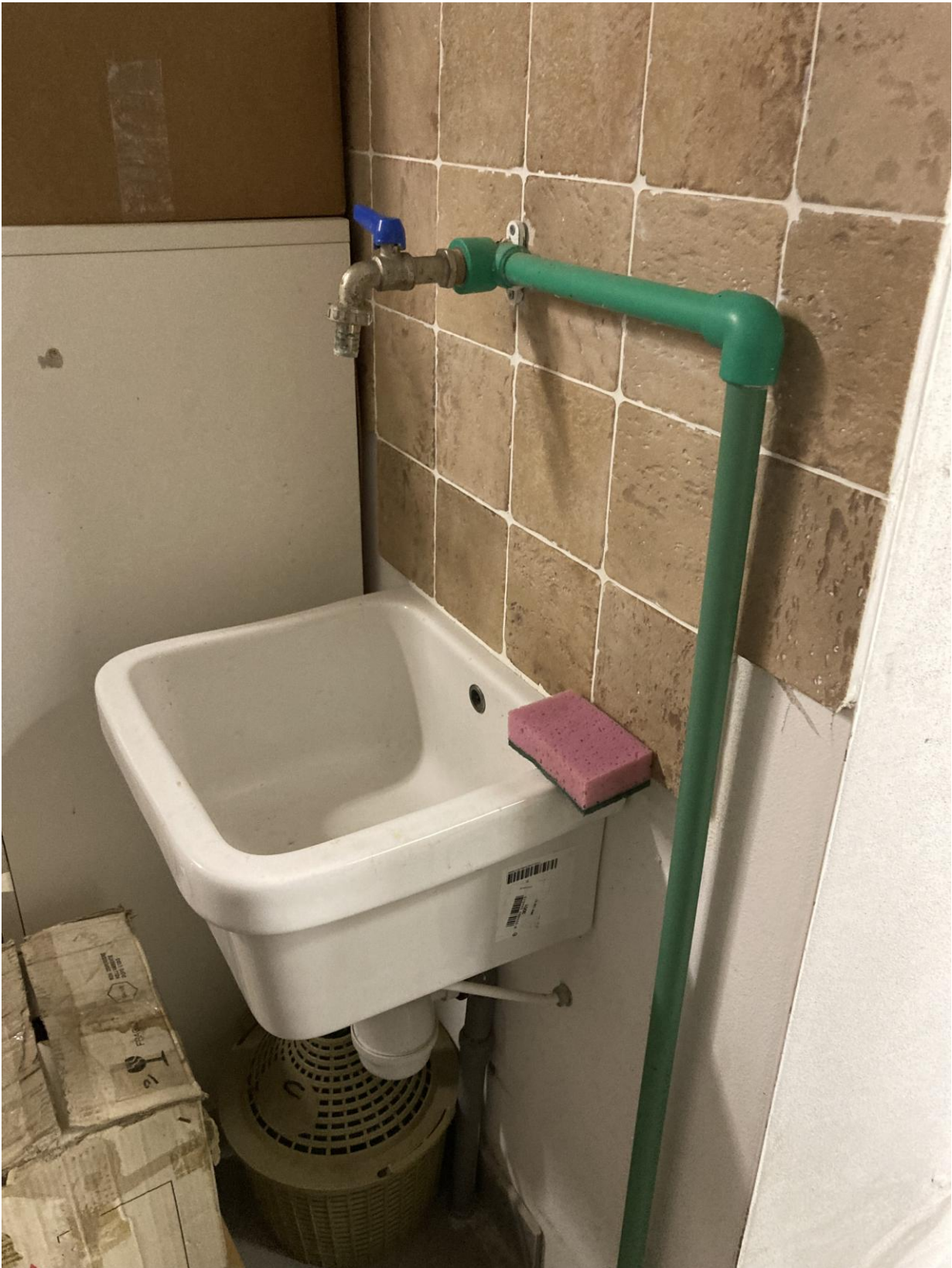
FOTO 26– PARTICOLARE DEL LAVANDINO ALL'INTERNO DEL GARAGE
