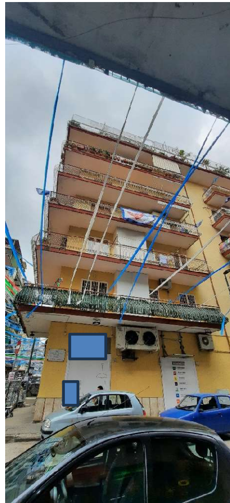
Foto n. 8_ fabbricato in Napoli alla via F Arnaldi 48
