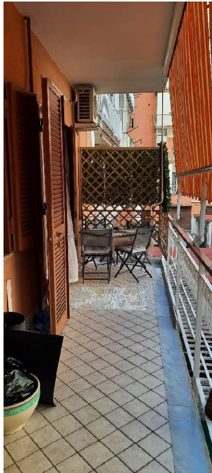
Foto n. 3 _ Particolare di una balconata dell'immobile esaminato
