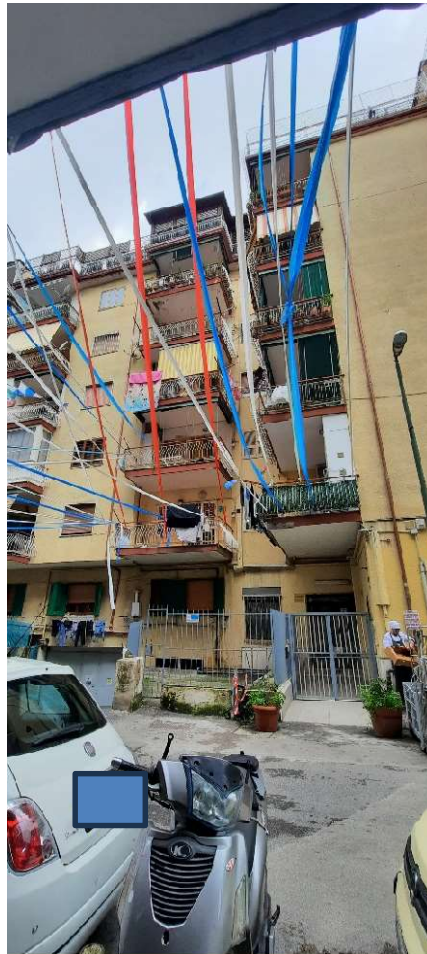
Foto n. 1 _ fabbricato in Napoli alla via F Arnaldi 48
