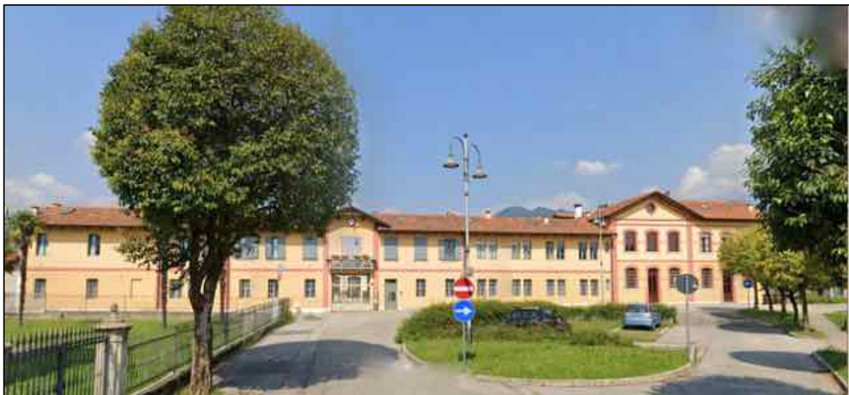
Foto esterna da via Riboli
