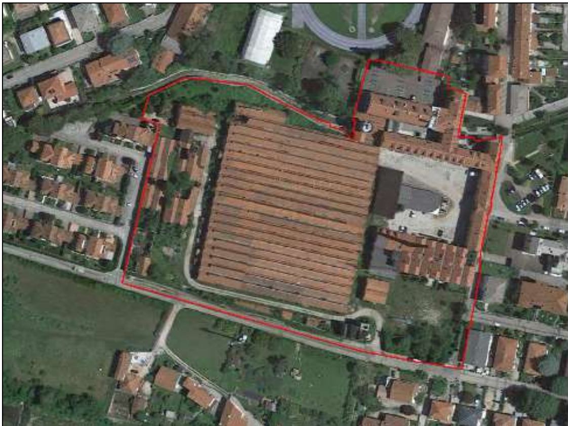
foto aerea con individuazione del complesso "Ex Lanificio Cazzola" Fg 11m.nn. 193-194-195-1919
