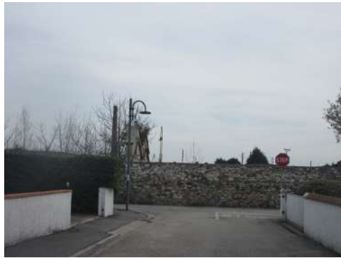
sub 13 muro da via Hemingway
