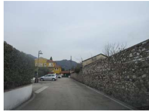
sub 13 muro da via Hemingway
