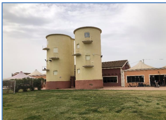
Foto n°62 - vista deposito carrelli - officina
