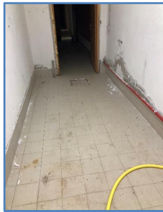
Foto n°83 - 84 - 85 - 86 - 87 - 88 - particolari delle infiltrazioni al piano interrato
