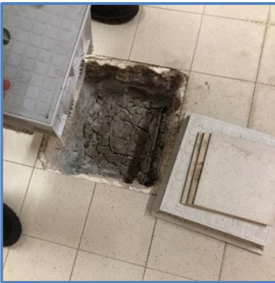
Foto n°83 - 84 - 85 - 86 - 87 - 88 - particolari delle infiltrazioni al piano interrato
