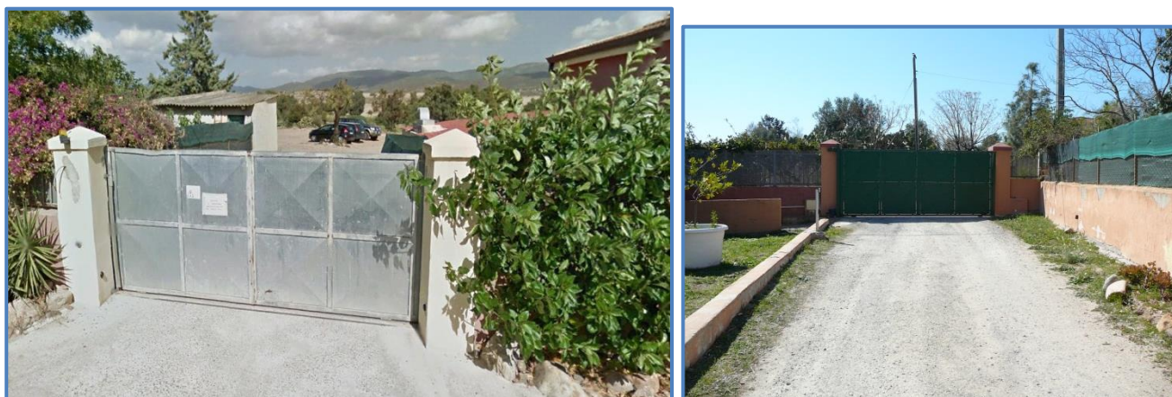
Foto n°5 - 6 - ingresso carrabile sulla via Bouganvillee del mappale 400 di proprietà di terzi
