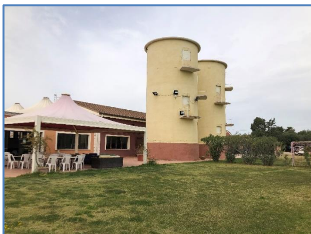
Foto n°61 - vista gazebo lato bar - ristorante
