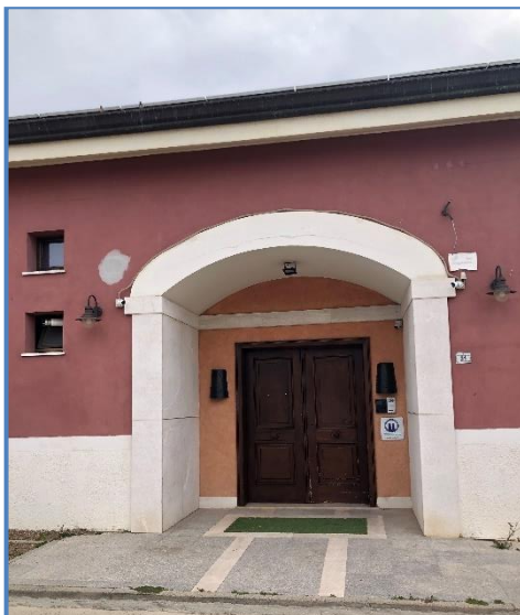
Foto n°10 - vista dell'ingresso pedonale della club house
