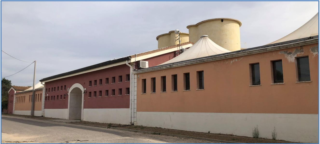
Foto n°9 - vista del prospetto principale
