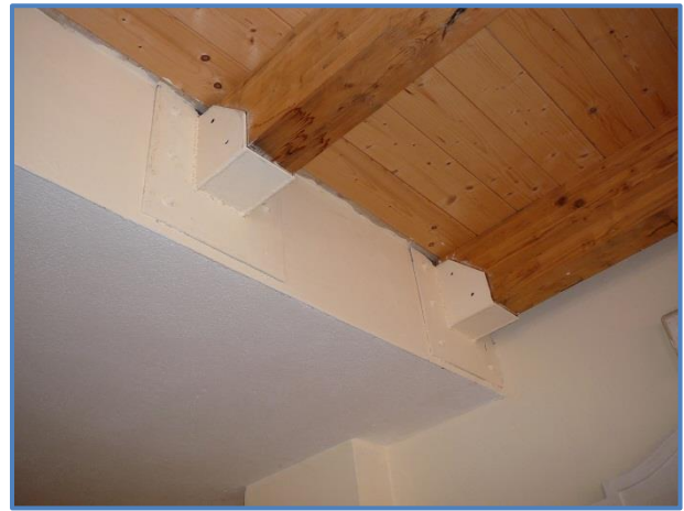
Foto n°51- 52 - vista dell'intradosso del solaio realizzato per l'ampliamento del soppalco
