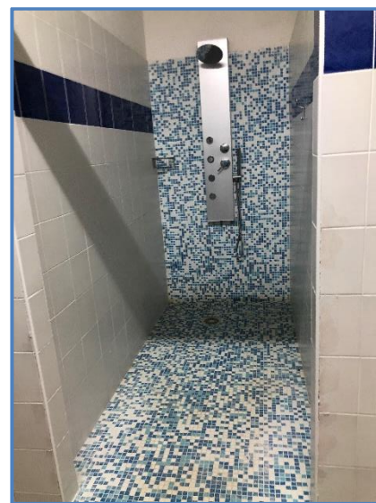
Foto n°82 - docce spogliatoi uomini - n.4
