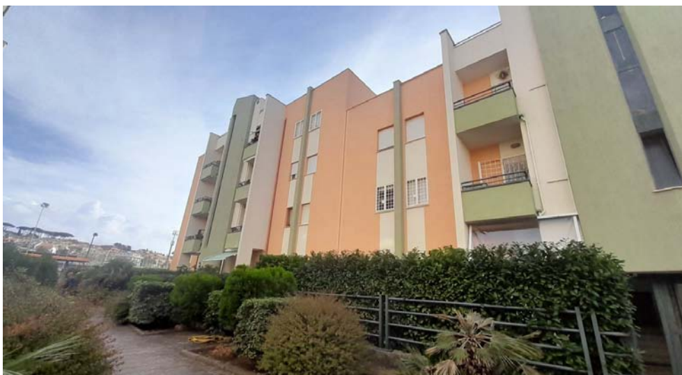
FOTO N. 2 – CONDOMINIO DI VIALE SPAGNA civ. 11
