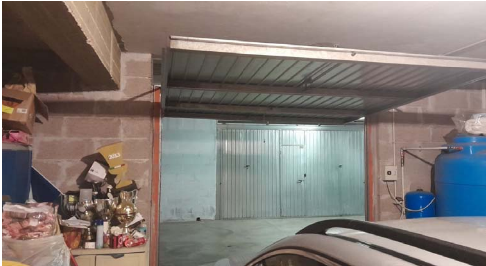
FOTO N. 7 – INTERNO DEL BOX AUTO, Fg.25, mapp. 391, sub. 46
