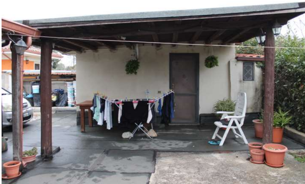
Vista lato ingresso con veranda ex magazzino
