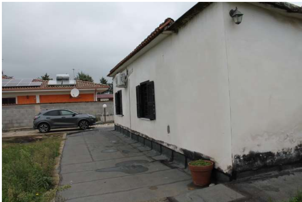
Vista lato fronte strada
