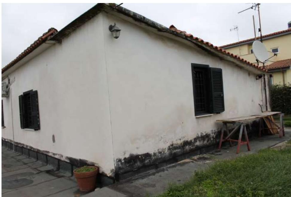
Vista lato destro
