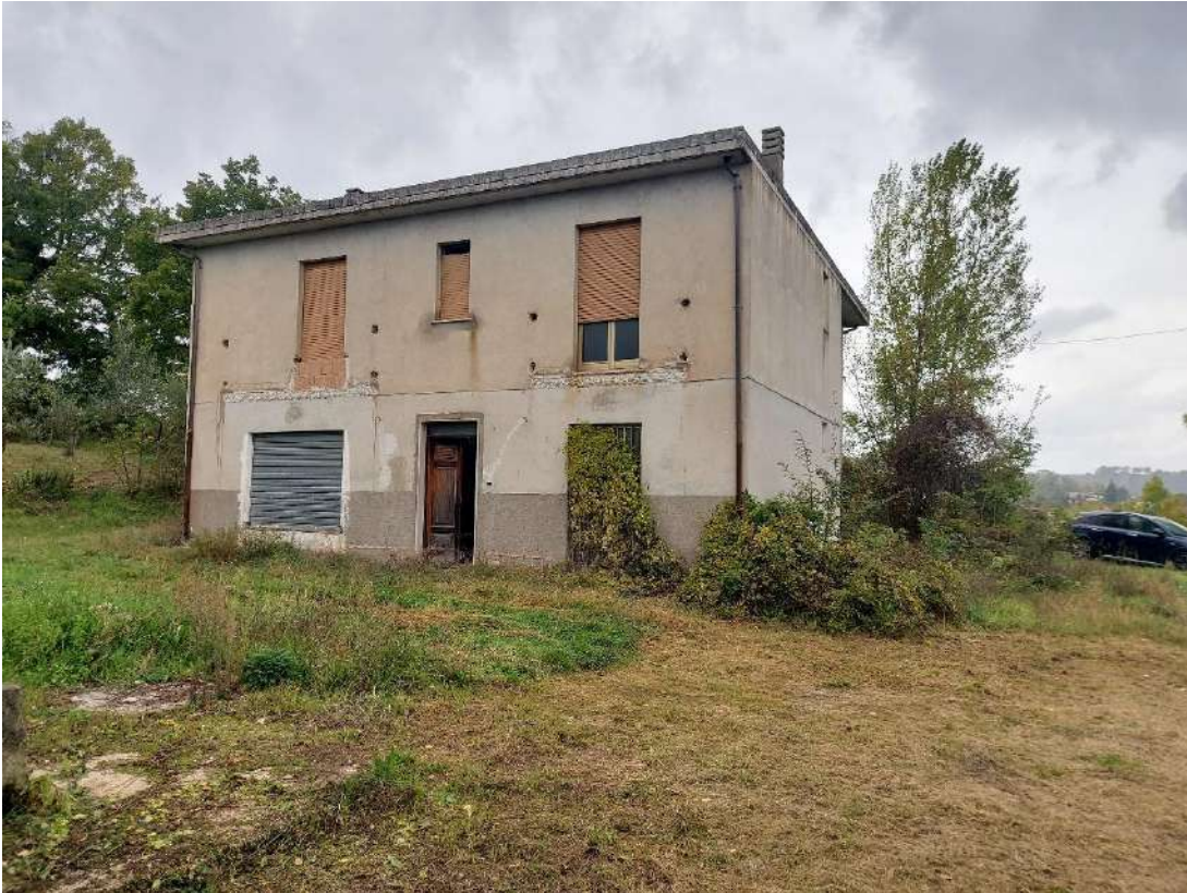
PROSPETTO LATO INGRESSO RESIDENZIALE
