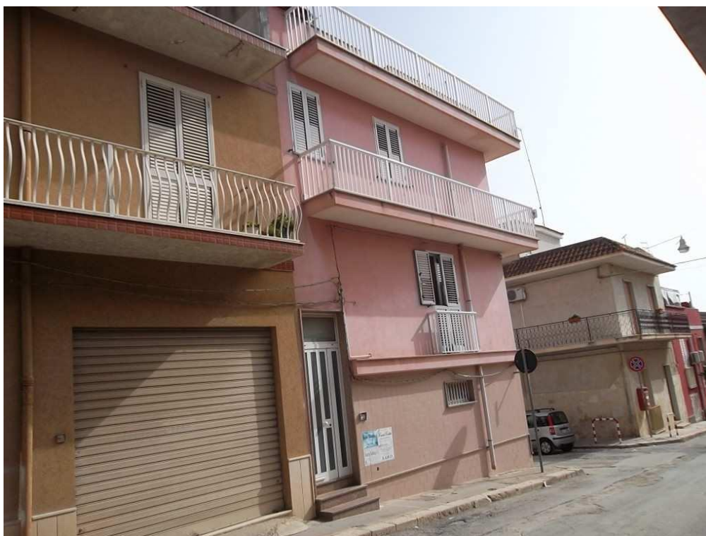
Foto 1 – Fabbricato “1A” - Prospetto principale su via Cassar Scalia
