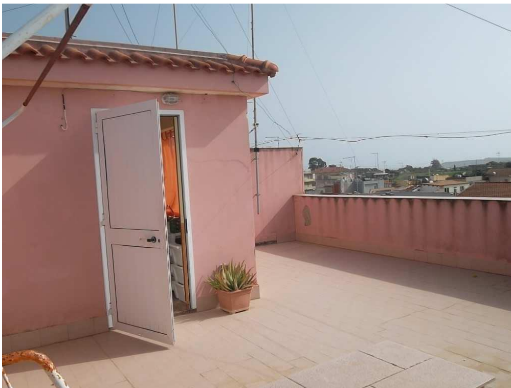
Foto 12 – Fabbricato “1A” – Piano III – Terrazzo e torrino vano-scala
