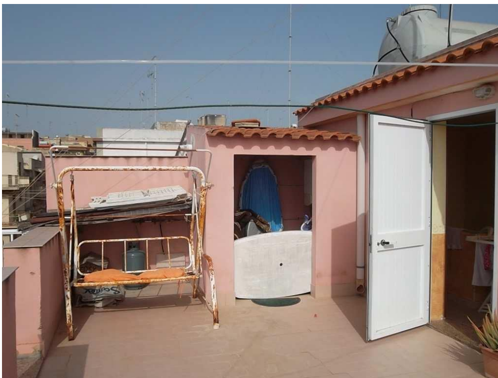
Foto 13 – Fabbricato “1A” – Piano III – Terrazzo e locale-caldaia
